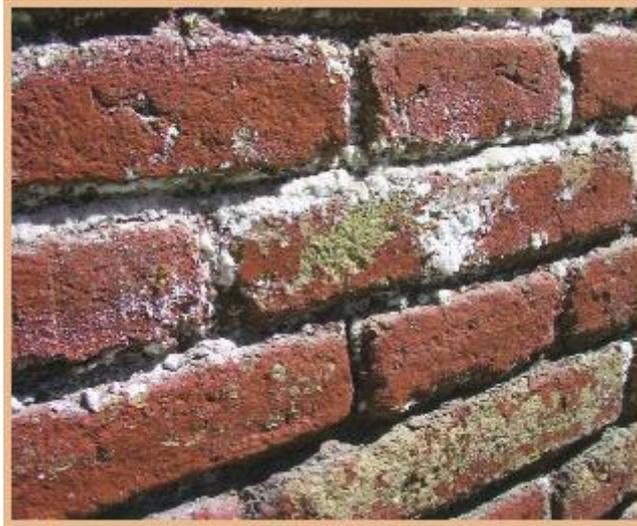
*Imagen 8: Eflorescencia en muros.*
