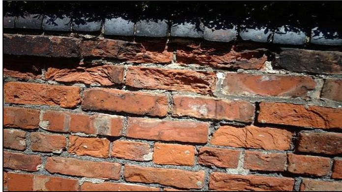
*Imagen 4: Erosión en muros.*
