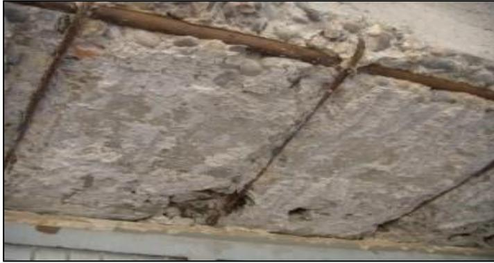
*Imagen 9: Oxidación en el acero de la estructura.*
