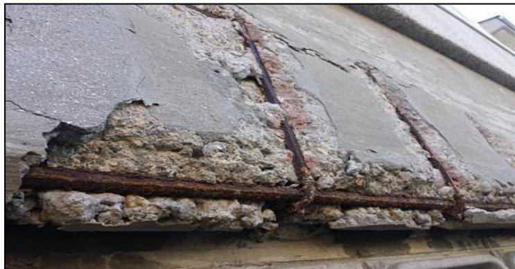
*Imagen 10: Corrosión en armadura.*
