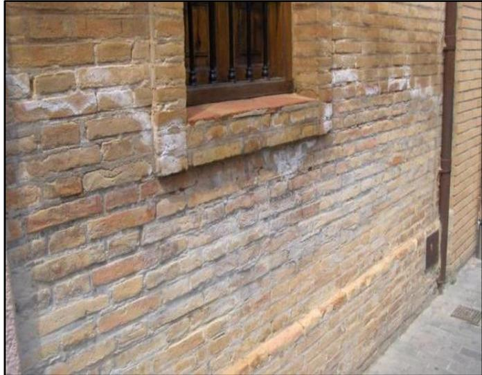
*Imagen 3: Humedad en estructura.*
