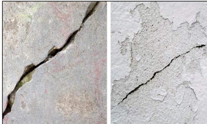
*Imagen 6:* Grieta y fisura en la estructura.
