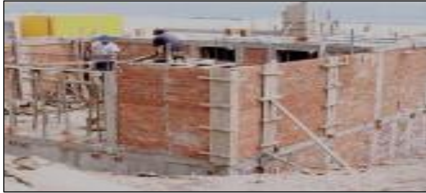
Imagen 3. Estructura- columna de concreto armado.
