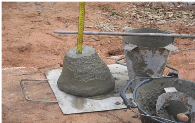
Imagen 1. Control del asentamiento del hormigón. Fuente: Saldaña M., Granada R. Paraguay 2009
