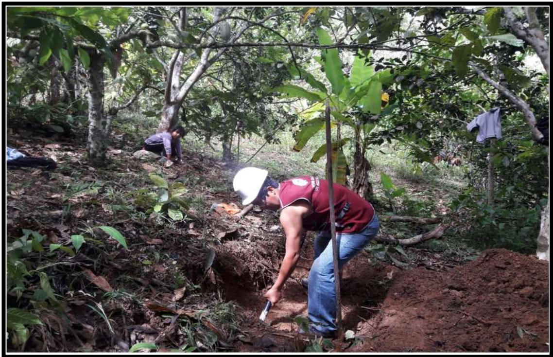
Foto 01: Vista panorámica de calicata para reservorio en la urbanización Bethel.
