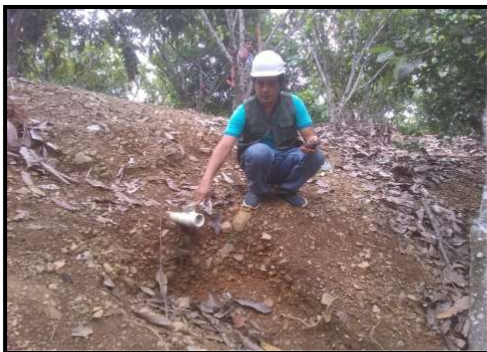
Foto 03: Vista panorámica de válvula de purga en la urbanización Bethel.
