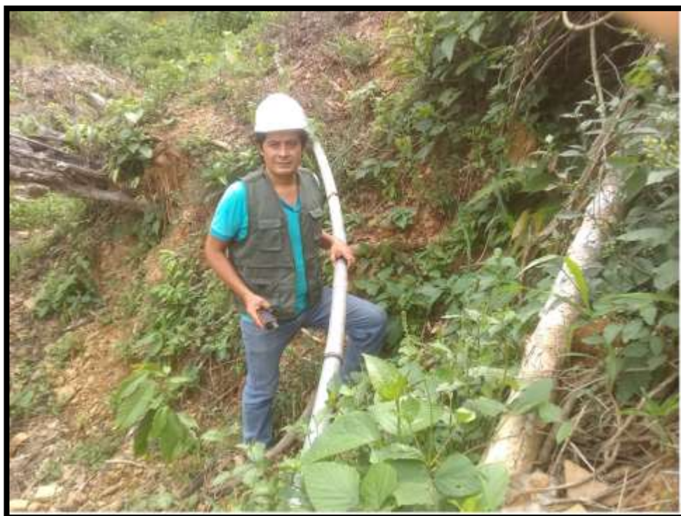
Foto 02: Vista panorámica de línea de conducción superficial.
