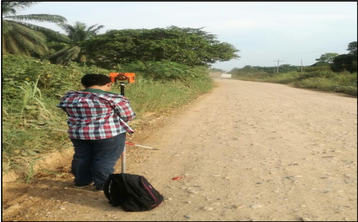
Fotografía 05 : Se hace el levantamiento topográfico del caserío y la accesibilidad del mismo.
