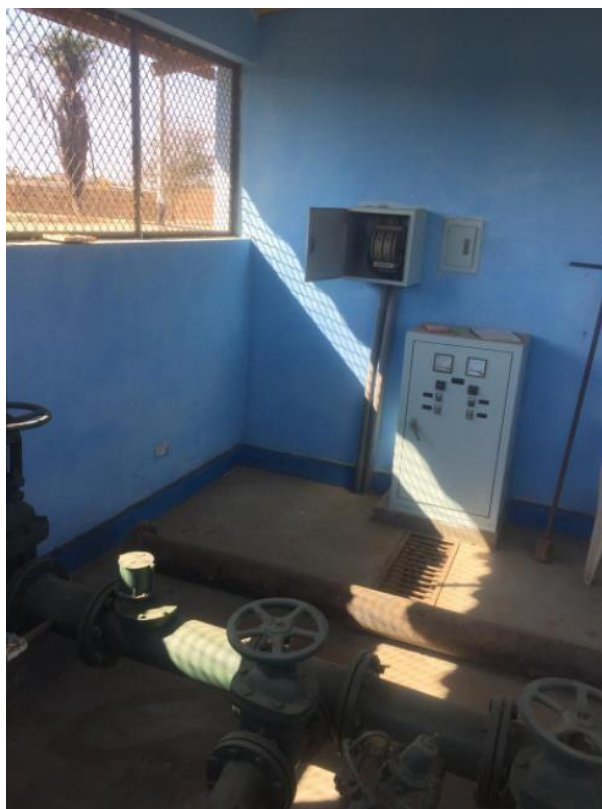
ILUSTRACIÓN 2 CASETA DE CONTROL -CENTRO POBLADO MONTE CASTILLO- IMAGEN PROPIA
