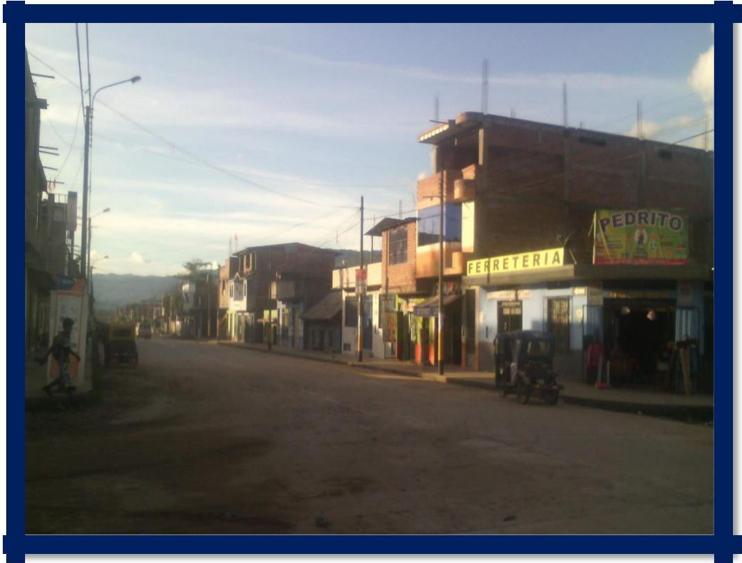
Figura 92. Fotografía panorámica de la avenida las Malvinas cuadra 03.
