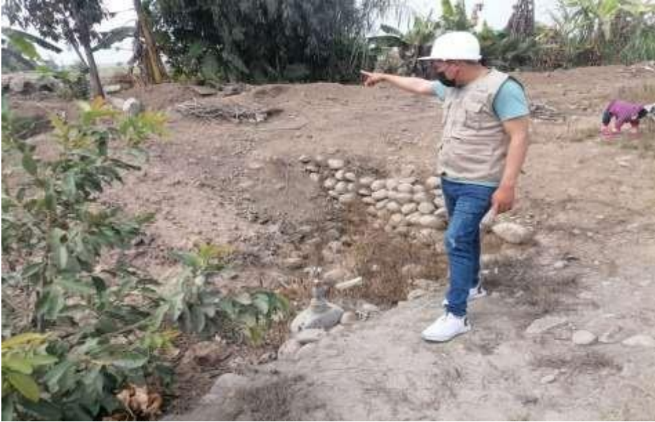
Fotografía 3 Vista hacia el inicio de la red de distribución
