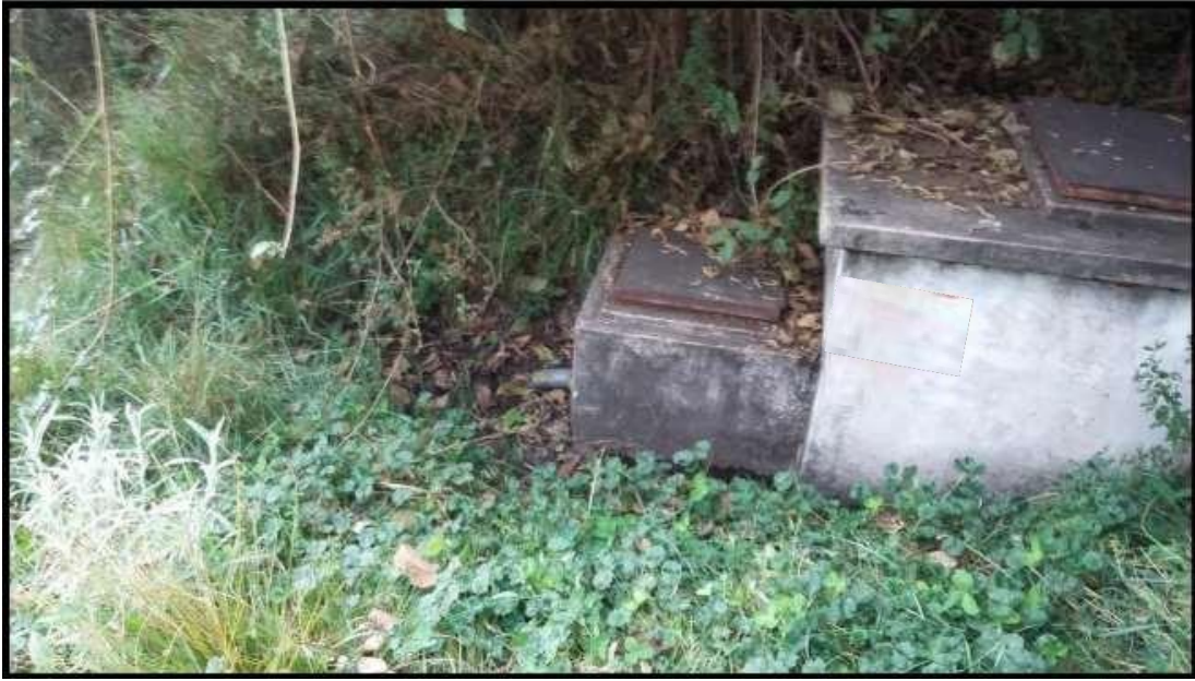
Fotografía 5 cámara de captación
