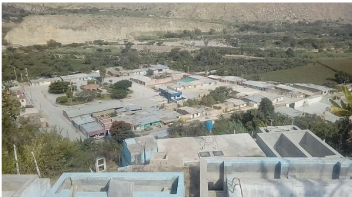
En esta fotografía se observa parte del reservorio en funcionamiento del centro poblado Salitre.
