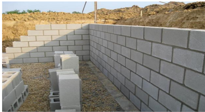
Imagen 02: Cerco de albañilería no confinada.
