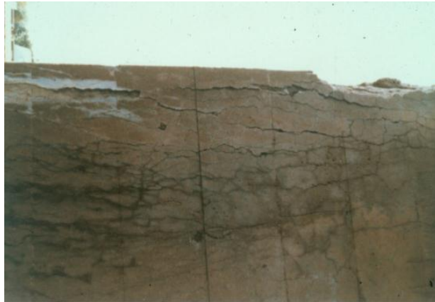
Imagen 17: delaminación.
