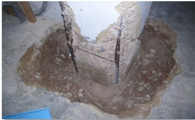
Imagen 18: Corrosión.
