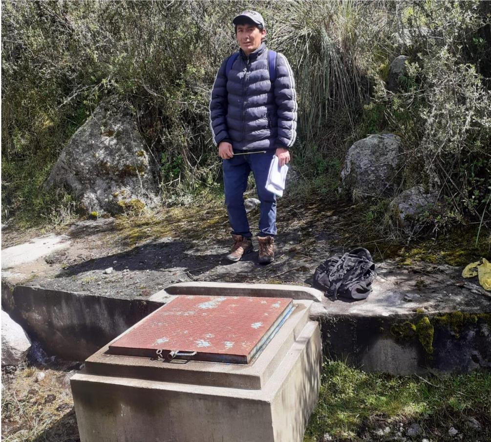
**Fotografía 02.** Vista de la cámara de captación del caserío de *Unchus*.
