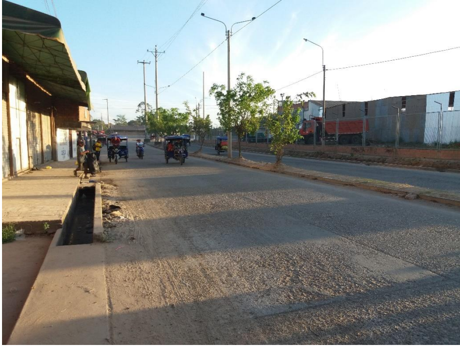
Figura 49: Vista panorámica de la cuadra 01 de la avenida Habilitación Urbana Municipal (2017)
