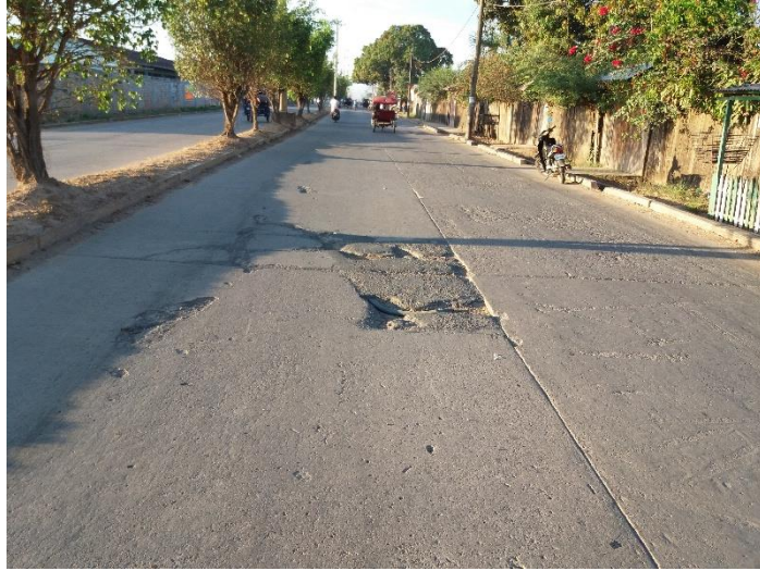
Figura 47: Vista panorámica de la avenida Habilitación Urbana Municipal (2017)
