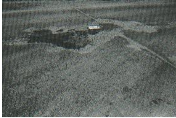
Figura 18: Desconchamientos / Mapa de grietas / Craquelado de alta severidad.
