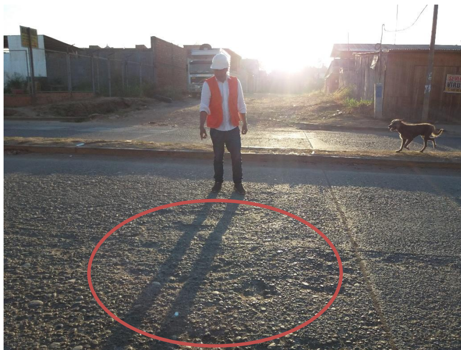
SEGUNDA CUADRA DE LA AVENIDA HABILITACION URBANA MUNICIPAL-CALLERIA-CORONEL PORTILLO- UCAYALI
