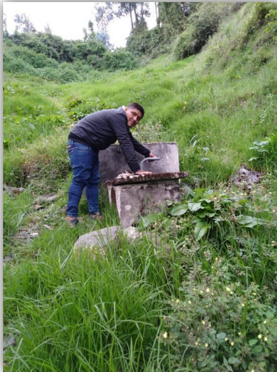
Imagen 02: cámara de captación del caserío
