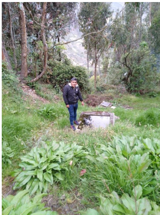
Imagen 03: quebrada del caserío, cámara de captación
