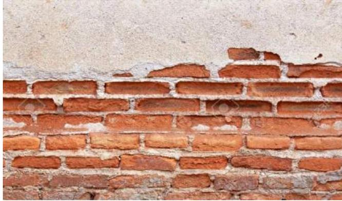
Imagen 13: Erosión en muro.
