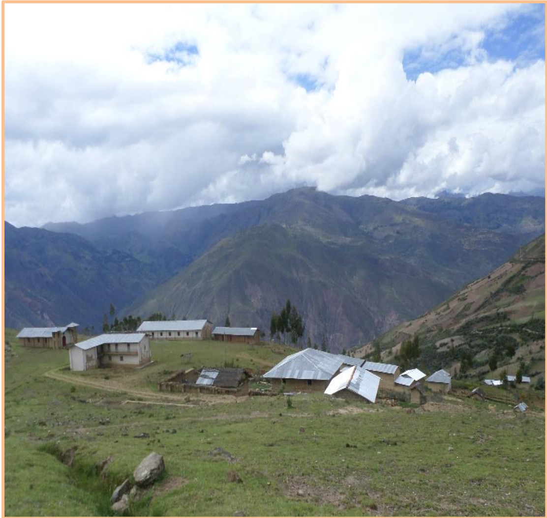
Imagen 03. Vista panorámica de las viviendas en el caserío de Colcabamba.
