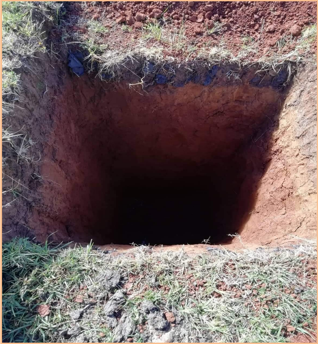
Imagen 06. Se observa la Calicata en el reservorio
