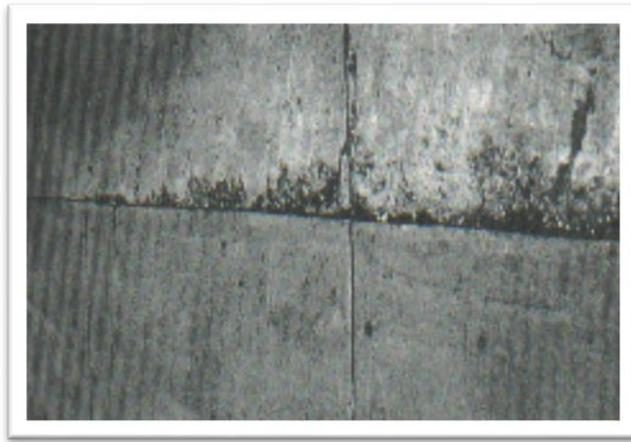
*Figura 26:* Descascaramiento de Junta
