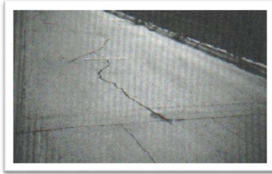
*Figura 10:* Losa Dividida.
