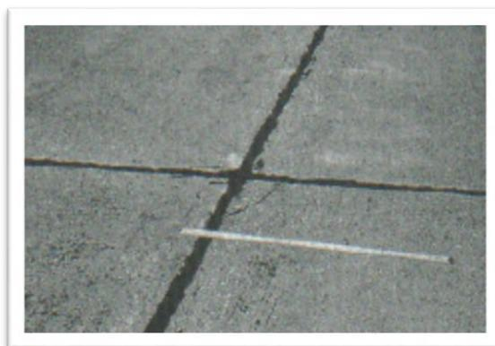
**Figura 25:** Descascaramiento de Esquina
