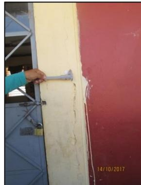
Foto 14 Eje II-22, columna 8 – Patología: Fisuras
