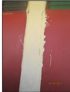
Foto 13 Eje HH-22, columna 7 – Patología: Fisuras
