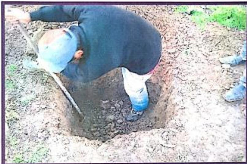
FOTO N° 01.- OBSERVAMOS UN PRIMER ESTRATO DE (SW) ARENA GRUESA BIEN GRADUADA, COMPACTADA, HUMEDA, DE POCA PLASTICIDAD, RICES Y GRAMA, NO HAY PRESENCIA DE NIVEL FREÁTICO.
