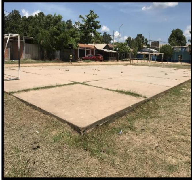
Plataforma deportiva Roca Fuerte
