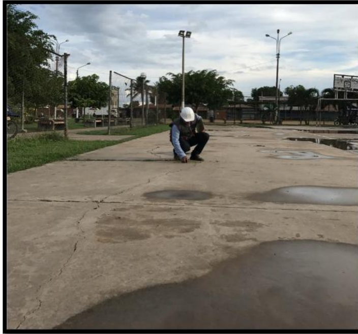
Plataforma deportiva Roca Fuerte
