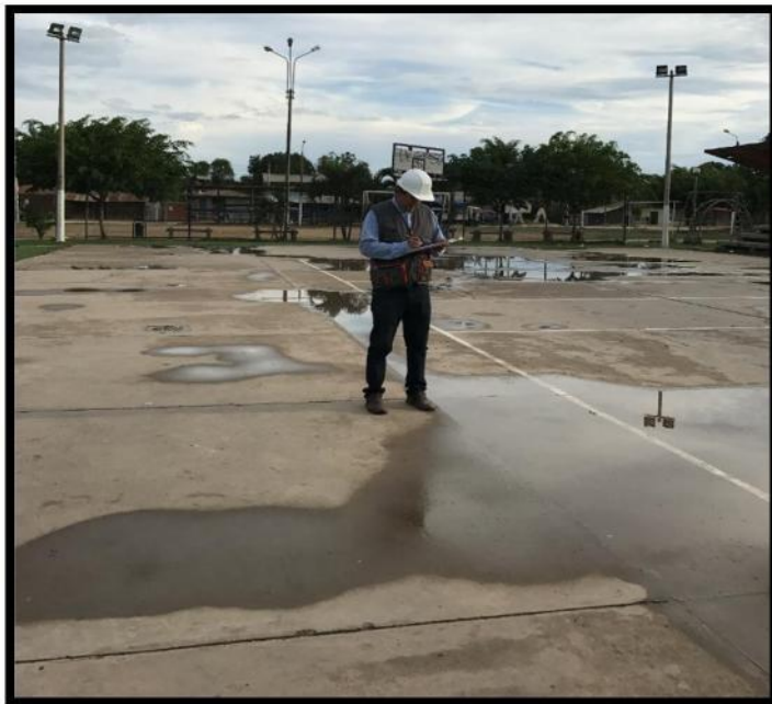
Plataforma deportiva Roca Fuerte
