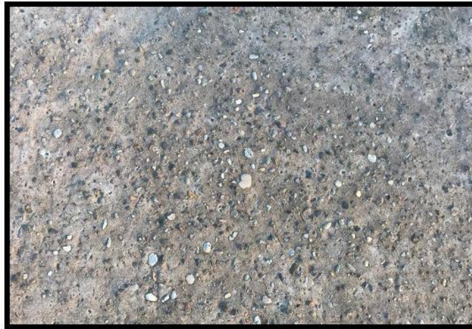
Pulimento de agregados
