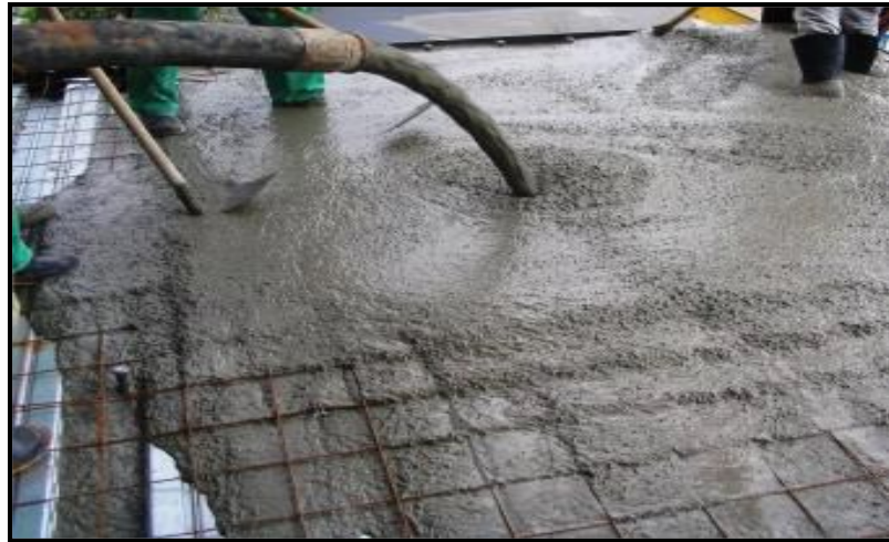
FIGURA 4: Imagen de concreto en estado líquido
