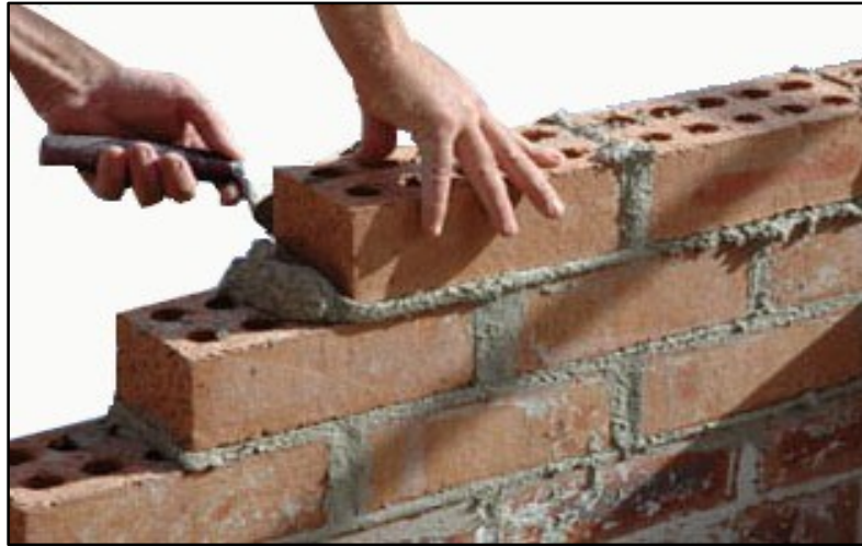
FIGURA 3: Imagen de albañilería simple
