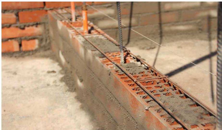
Figura 02. Imagen de albañilería armada
