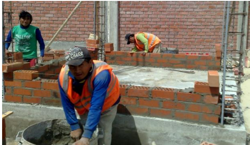
Imagen 02: Albañilería armada o confinada
