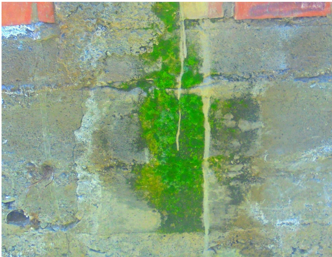
Imagen 31: Liquen en muro.
