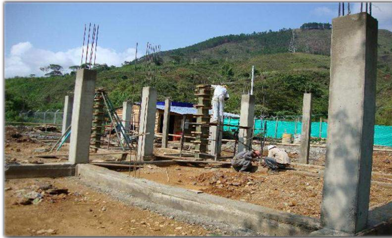
Imagen 16 – Columnas de concreto armado.
