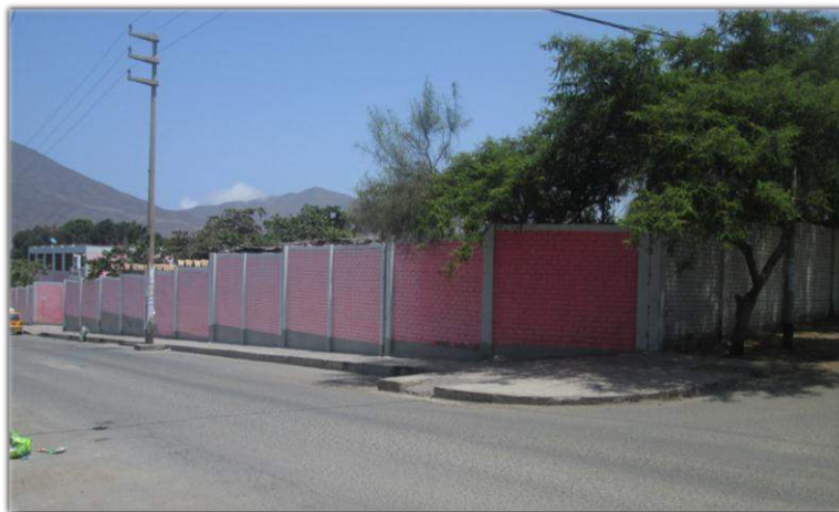
Imagen 11 – Cerco perimétrico de las Institución Educativa Pedro Ruiz Gallo
