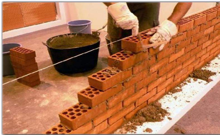
Imagen 12 – Elaboración de muro de albañilería.
