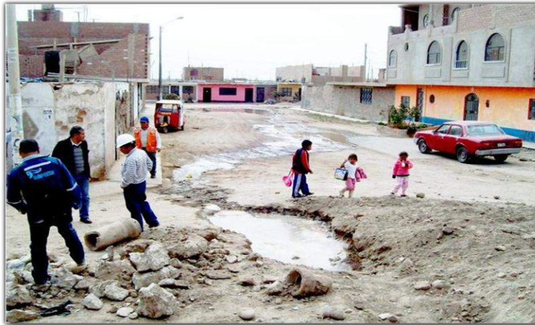
Imagen 9 – Humedad por error en la instalación hidráulica sanitaria.
