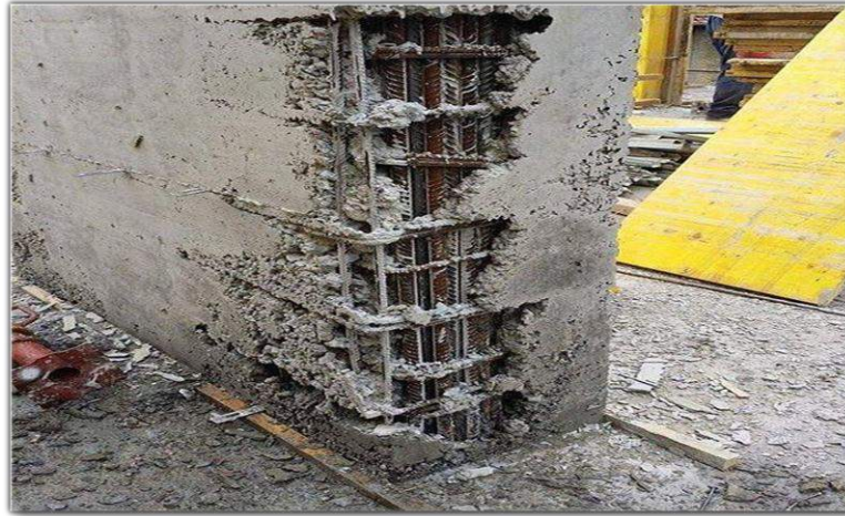
Imagen 25 – Cangrejera en elementos de concreto armado.
