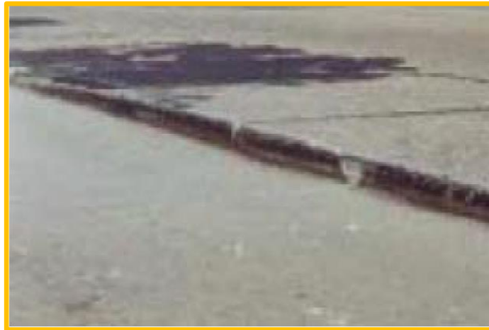
Figura II-17; Escalonamiento
