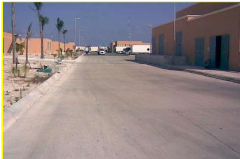
Figura II-5; Pavimento de Concreto Hidráulico Simple
