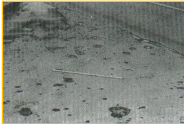
Figura II-24; Falla por Popouts
