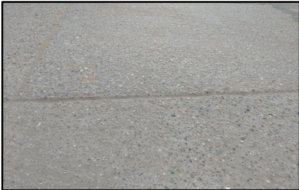
Figura 0-27; Pulimento de Agregado
