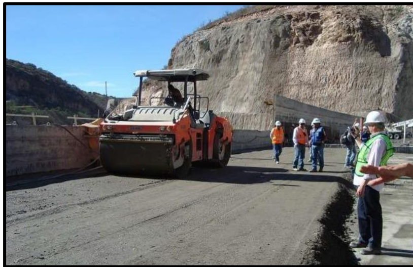
Figura II-11; Pavimento de Concreto Armado Compactado con Rodillo
