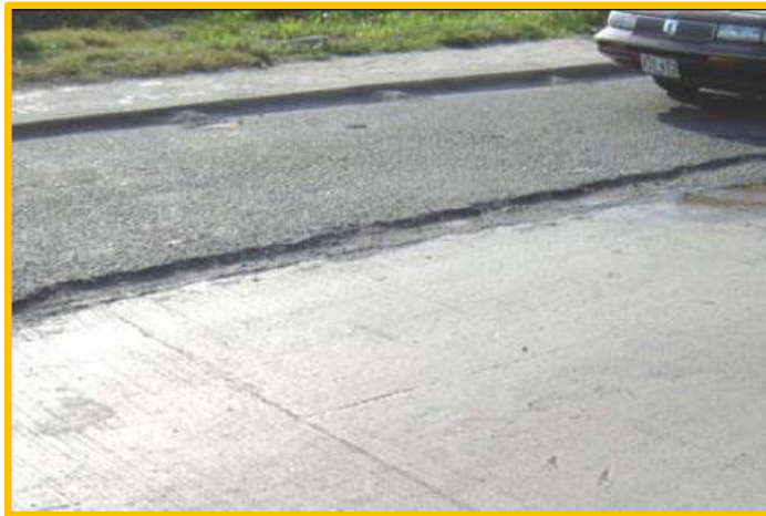
Figura II-23; Pulimento de Agregados
