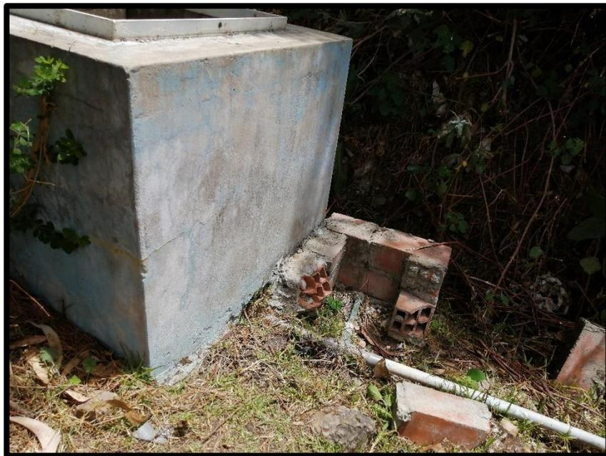
**Fotografía N°04:** En esta imagen se puede apreciar, salida de la línea de aducción sin protección.
