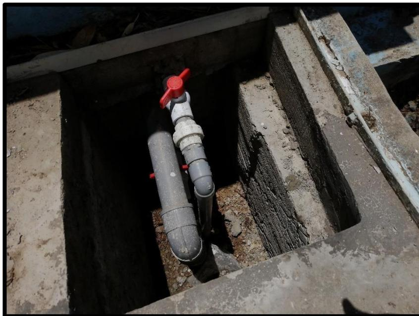
**Fotografía N°10:** En esta imagen se puede apreciar las tubería y accesorios de la caja de válvulas se encuentran en buen estado.
