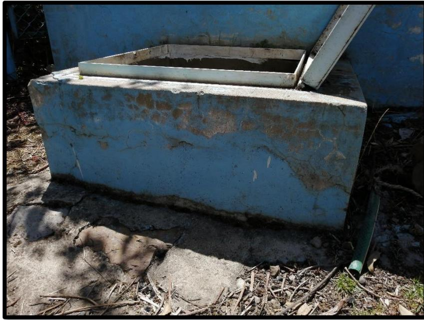
**Fotografía N°03:** Vista fotográfica donde se muestra que los muros de la cámara húmeda presentan fisuras.
