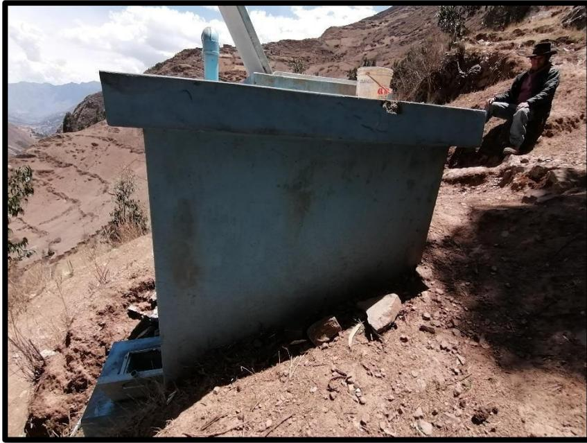
**Fotografía N°07:** En esta imagen se puede apreciar el reservorio no cuenta con cerco de protección y sistema de cloración.
