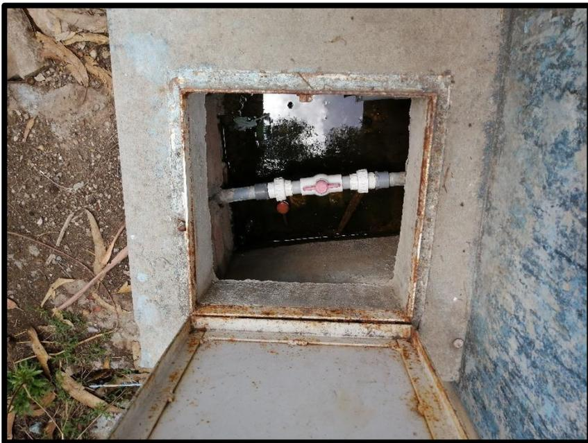
**Fotografía N° 02:** En esta imagen se puede apreciar, que la cámara de válvulas presenta filtraciones y las tapas metálicas presenta oxido.
