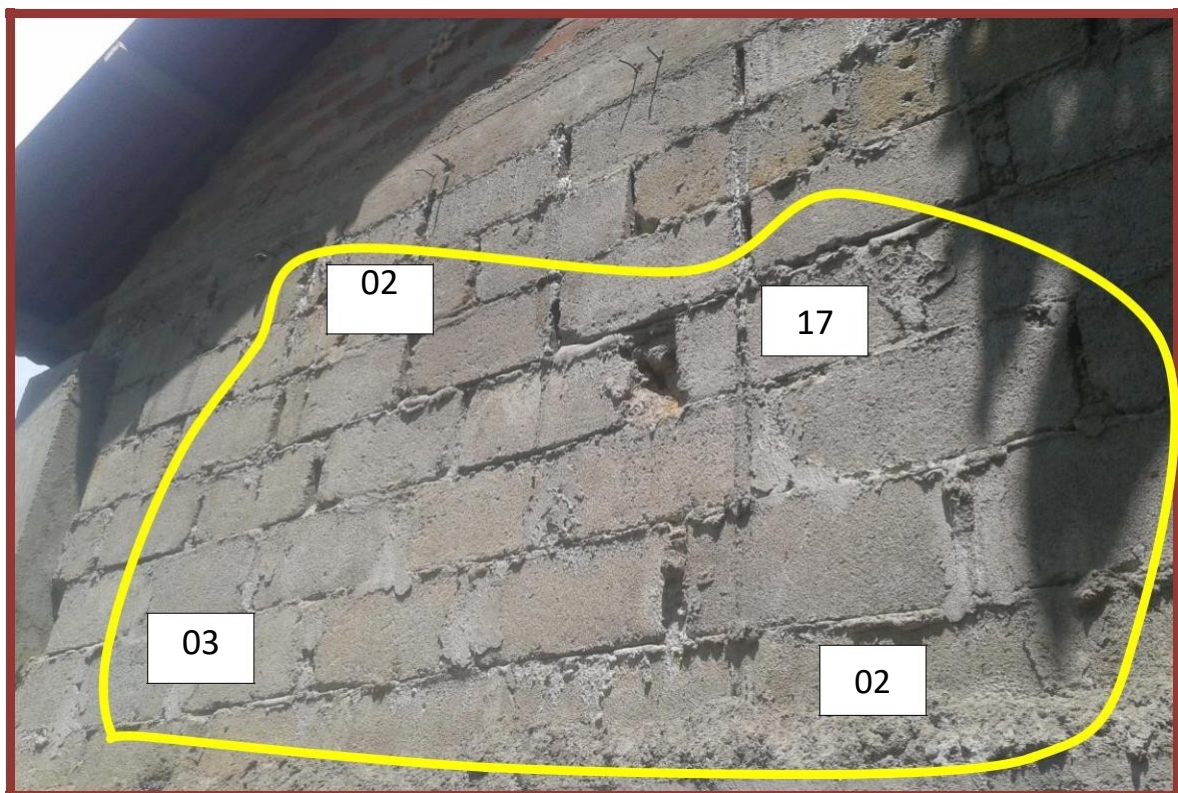
Figura 59. Vista posterior de la capilla muestra 03
