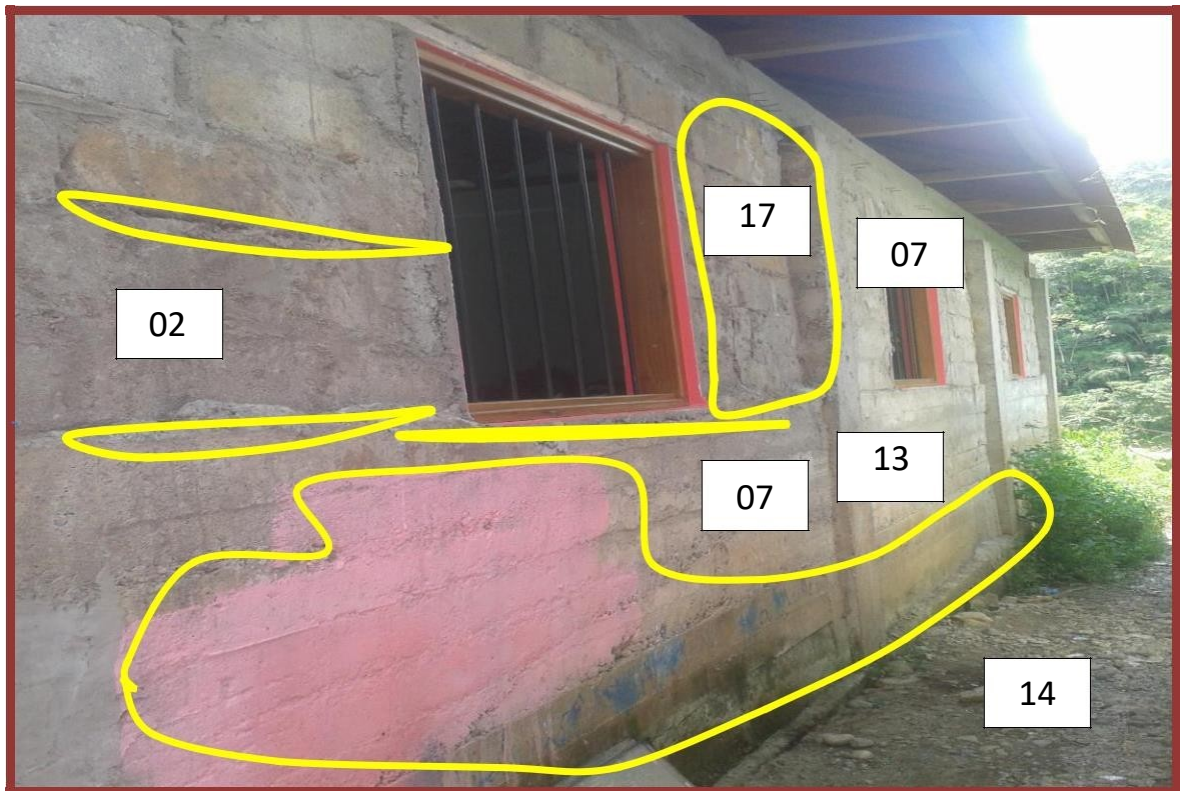
Figura 56. Vista vertical de la estructura de la capilla muestra 02
