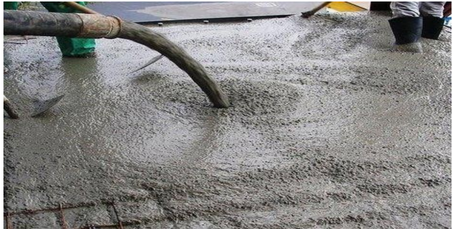
Figura 13: Exudación de concreto
