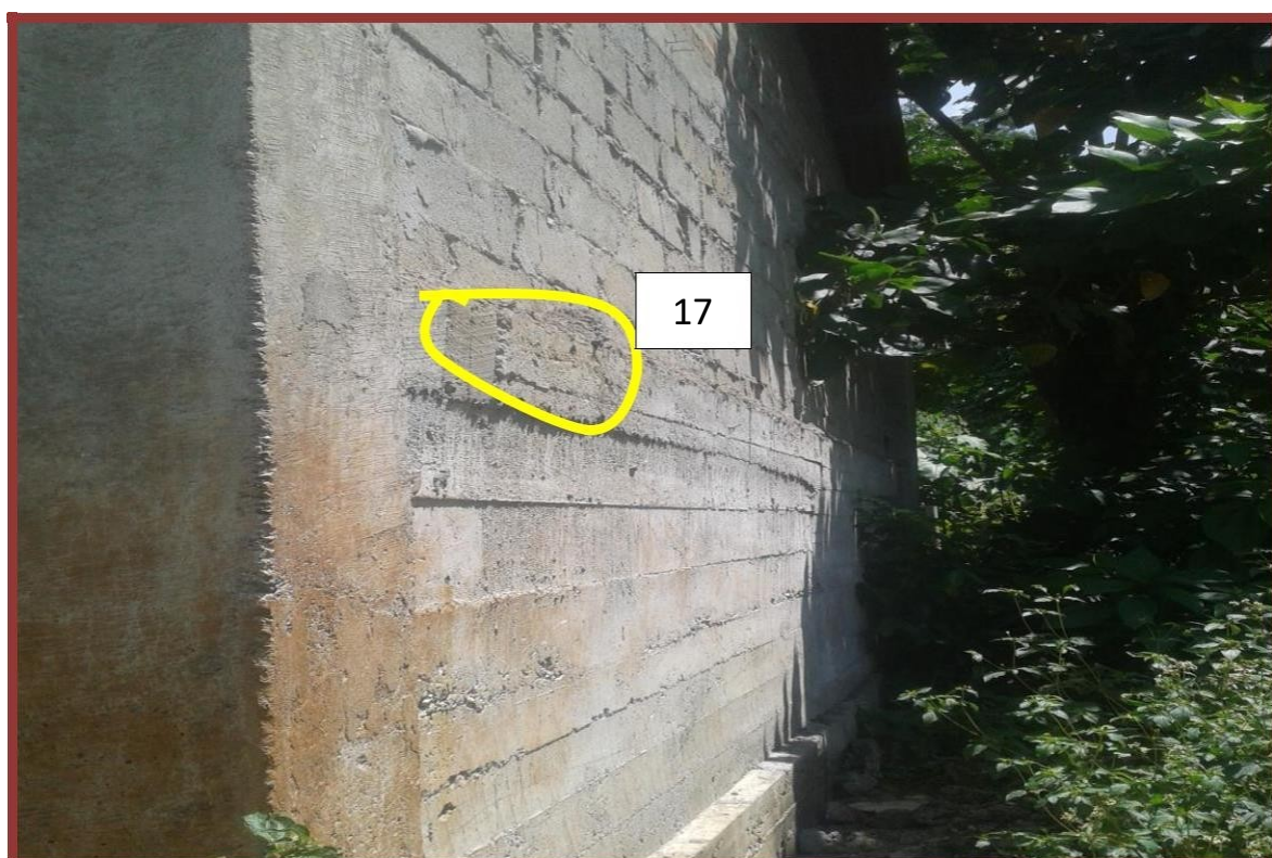
Figura 60. Vista posterior de la capilla muestra 03
