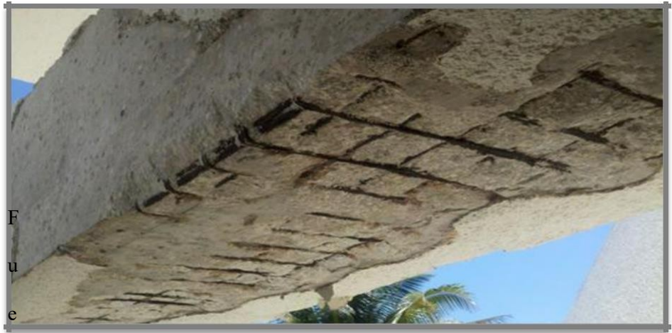
Figura 12: oxidación del acero
