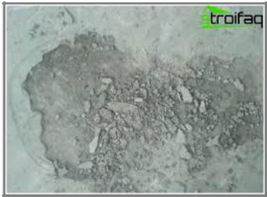
Figura 11: de laminación del agregados
