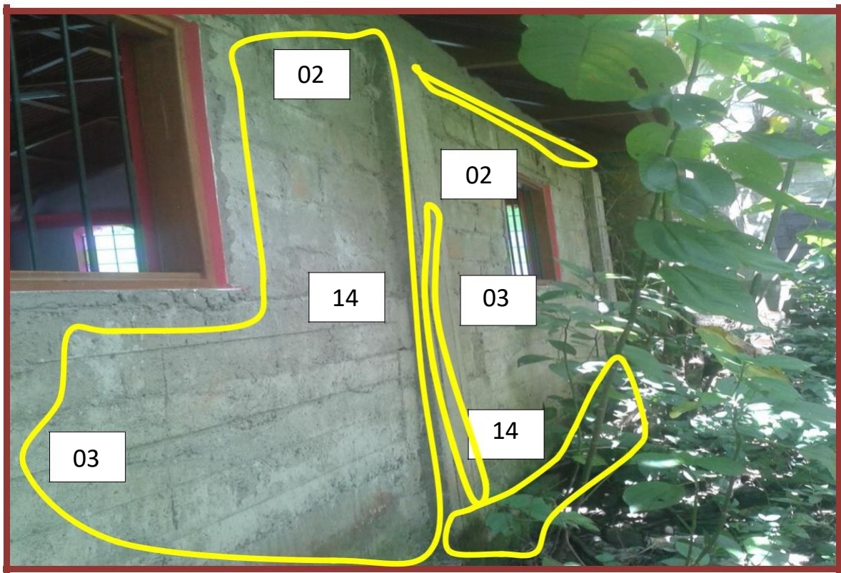
Figura 64. Vista posterior de la capilla muestra 04
