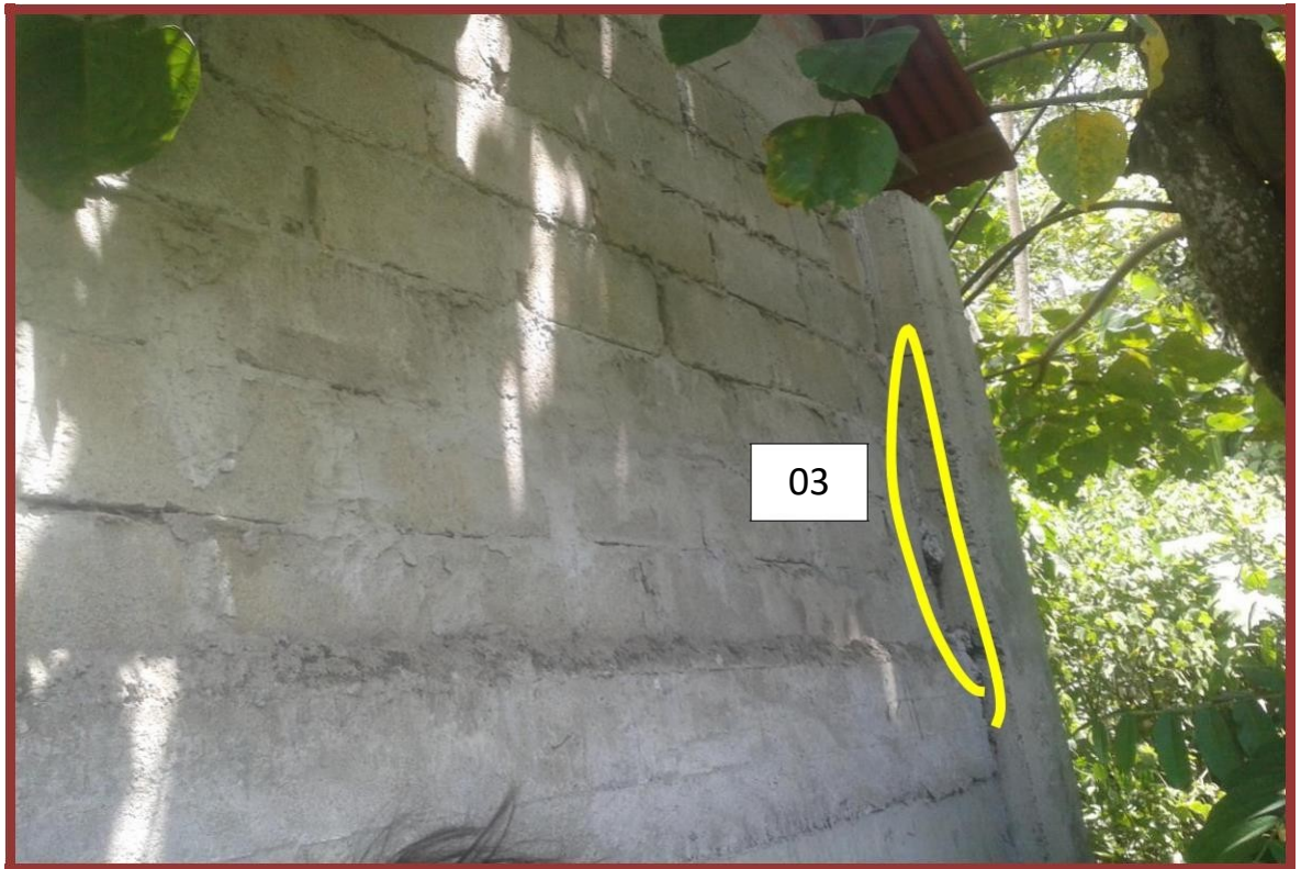
Figura 61. Vista posterior de la capilla muestra 03
