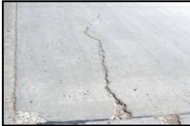
Figura 13: gráfico de falla superficial de un pavimento rígido
