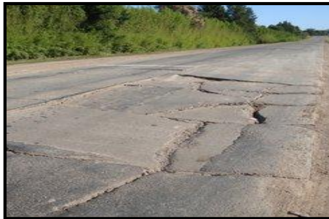
Figura 12: gráfico de falla estructural de un pavimento rígido
