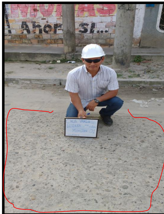
Figura 144: foto de pulimento de agregado
