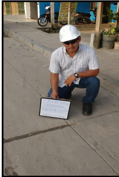
Figura 19: Descascamiento de Junta
