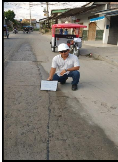
Figura 27: Grieta Lineales
