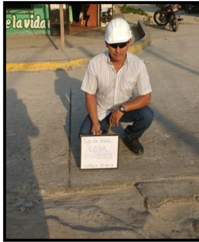
Figura 26: Losa Dividida
