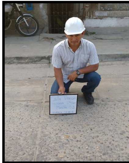
Figura 30: Pulimiento de Agregado
