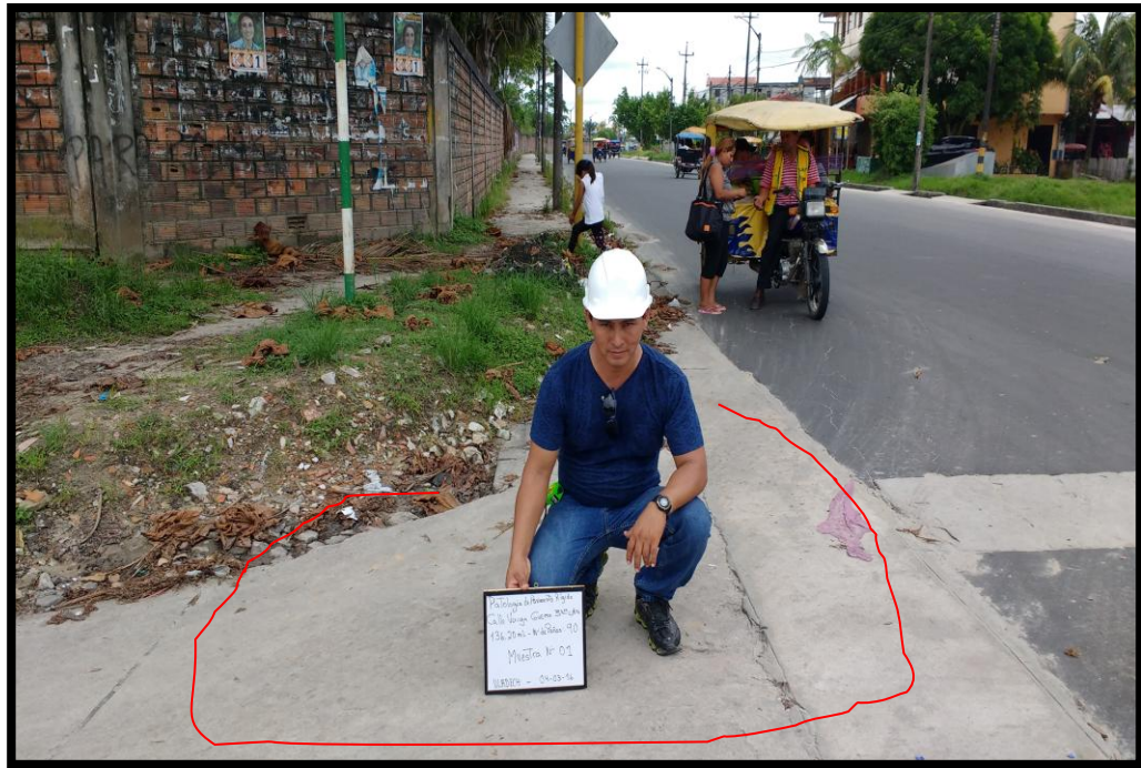
Figura 123: se observa grieta lineal de losa severidad media
