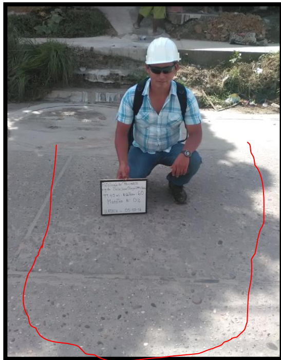
Figura 140: se observa pulimentos de agregados
