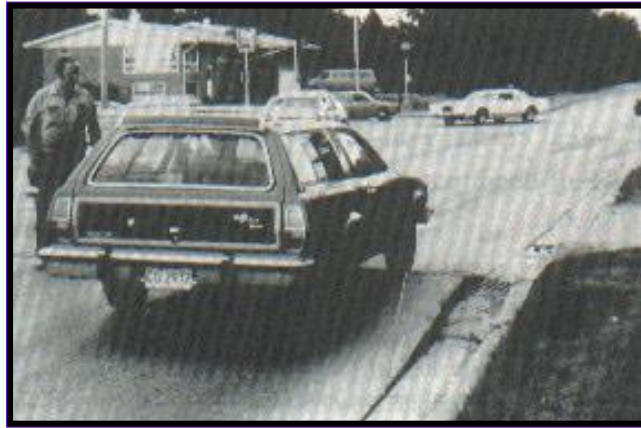
Figura 15: Falla por Blowups-Buckles
