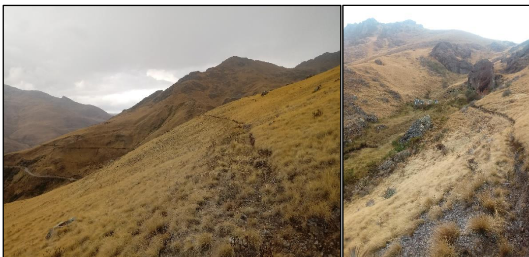
Foto 2: línea de conducción, recorrido en las laderas de los cerros.
