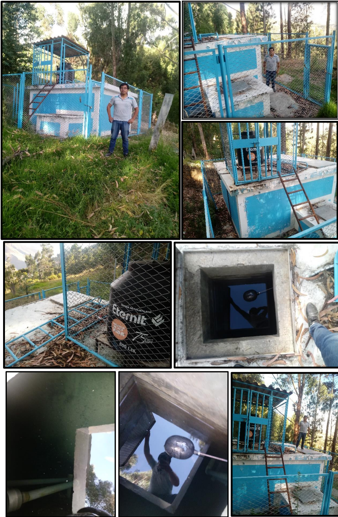
Foto 4: vista del reservorio de 20m 3 , interior y exterior.
