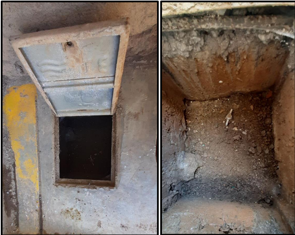
Foto 6: Sistema de alcantarillado, buzones y caja sanitaria.
