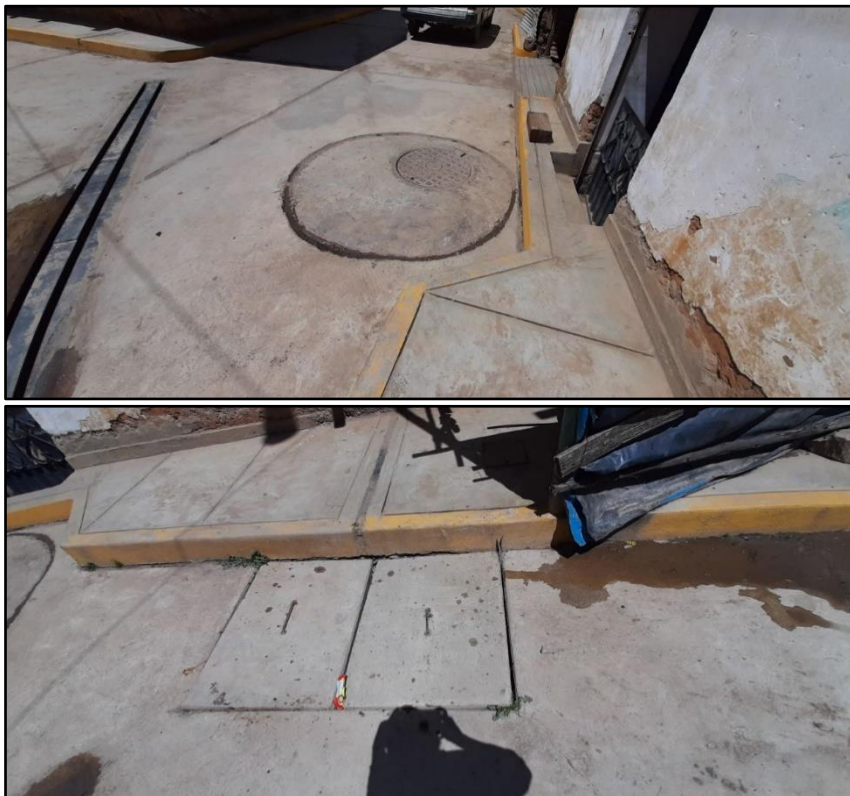
Foto 6: Sistema de alcantarillado, buzones y caja sanitaria.
