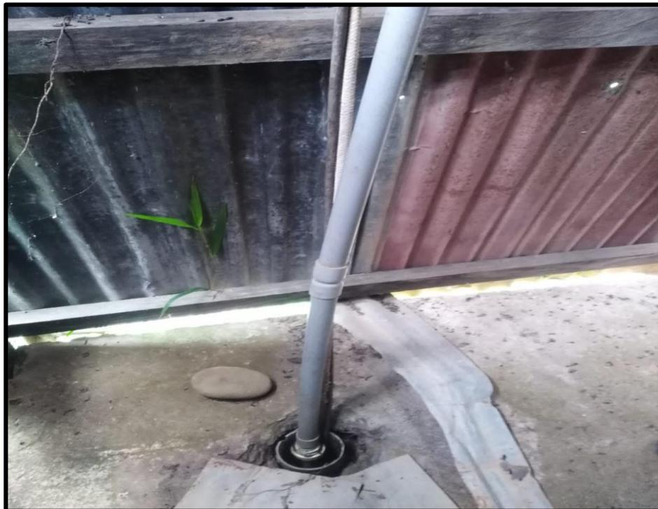
Fotografía 04: Interior de caseta, se observa línea de impulsión y sus respectivos accesorios (unión universal) y tubería de  $\varnothing 4''$  como revestimiento.
