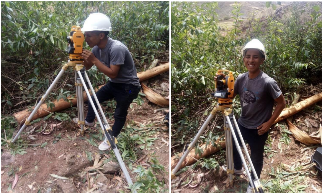
Figura 19: Levantamiento Topográfico de la línea de conducción.
