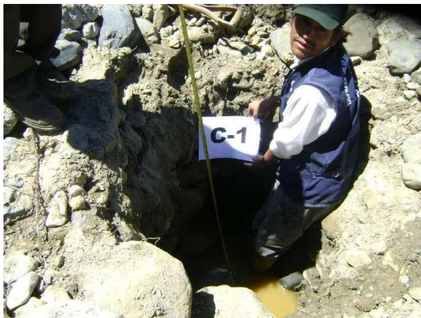
Foto 03: Vista de la calicata C-1
