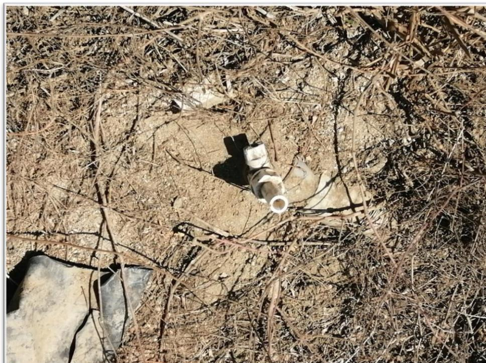
**Imagen 11:** Válvula de purga de la línea de aducción.
