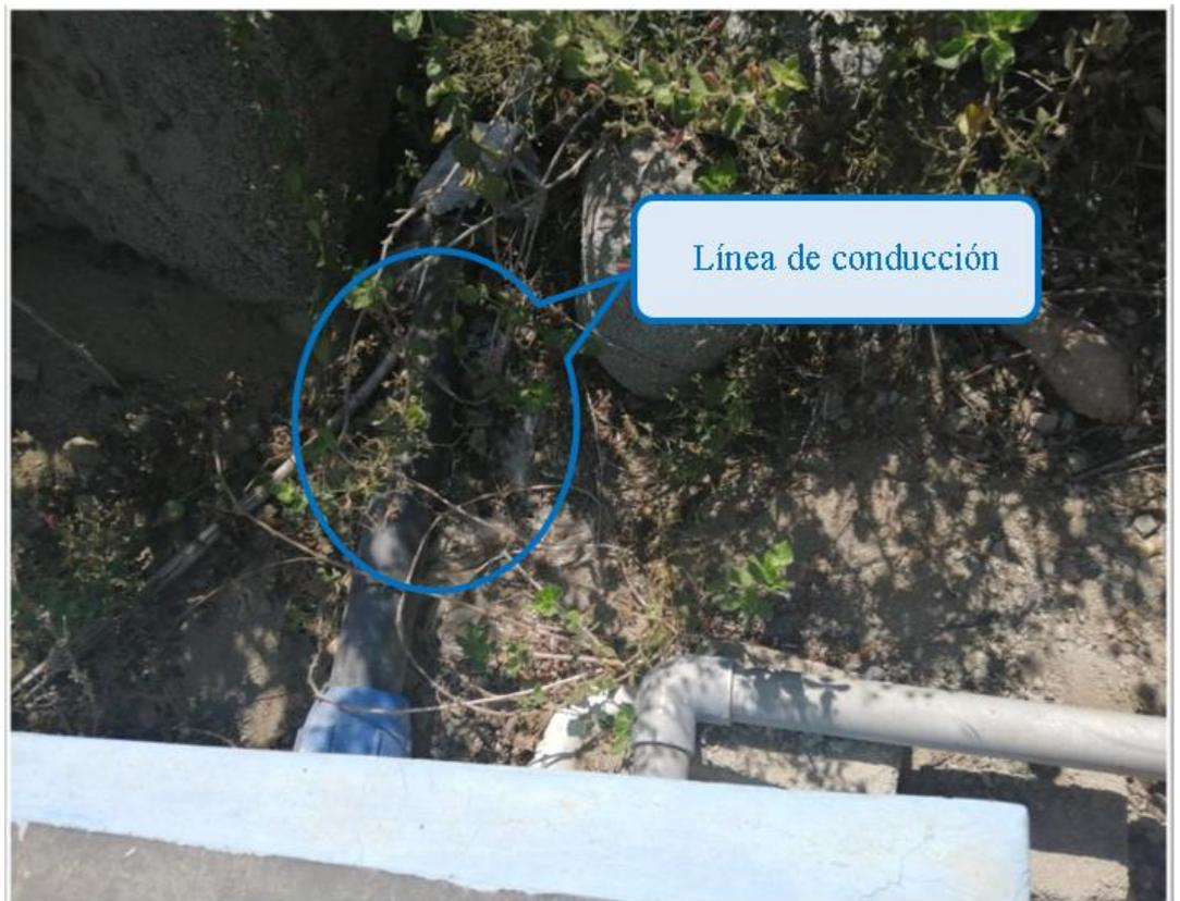
**Imagen 5:** Línea de conducción llegando al reservorio.
