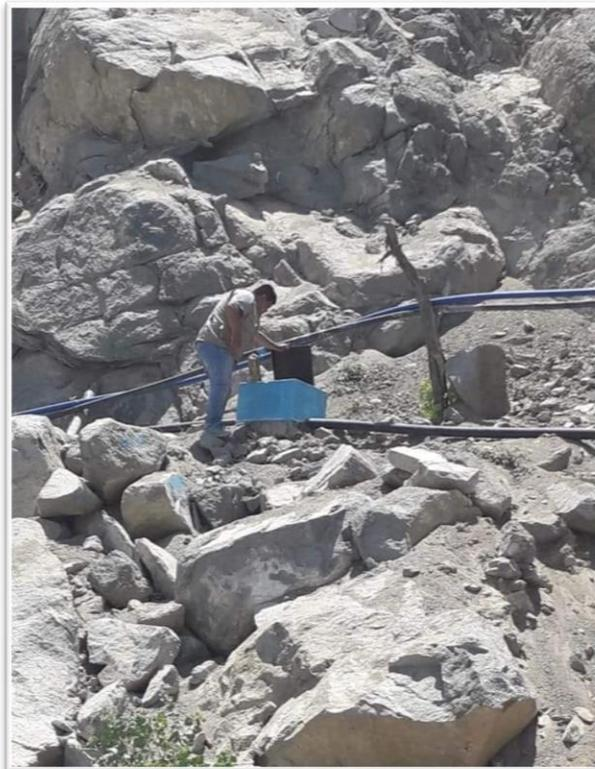
**Imagen 4:** Caja de válvula de aire.
