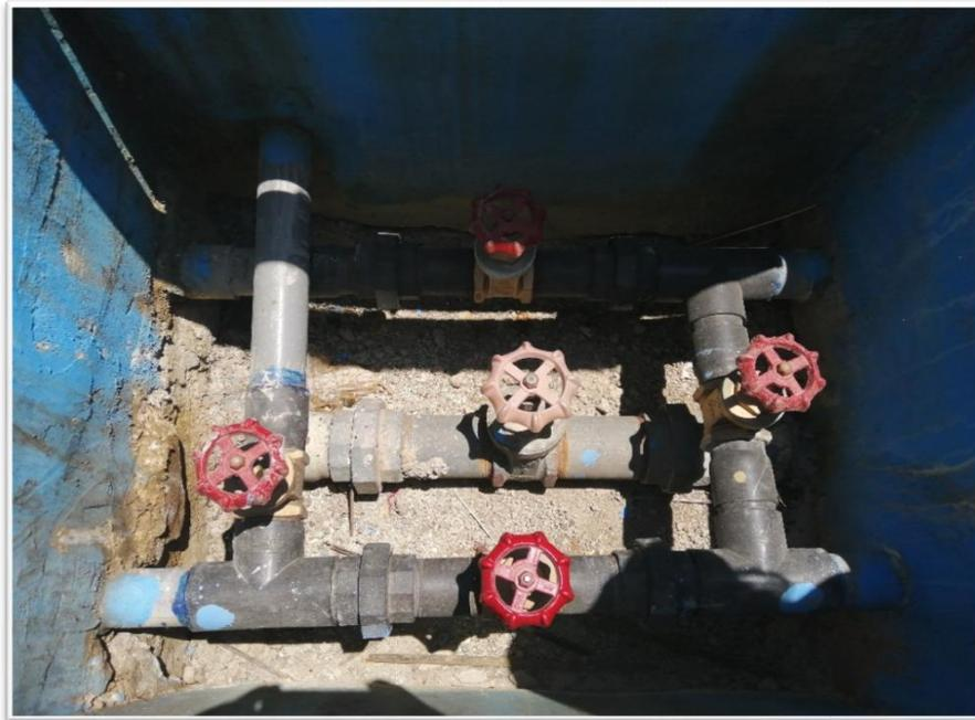
**Imagen 8:** Caja de válvulas del reservorio.
