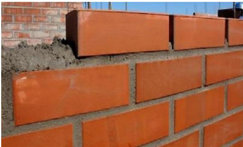
Figura 1. Unidades de Albañilería asentado con mortero
