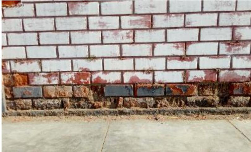
Figura 16. Muro de albañilería afectada por erosión química en la parte inferior producto de un suelo salitroso y húmedo.
