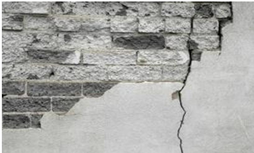
Figura 9. Grieta en muro producto de la deformación del apoyo de su cimiento.
