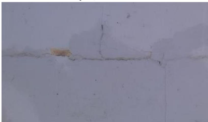
Figura 8. Aparición de fisuras sobre el acabado producto de esfuerzos mecánicos.
