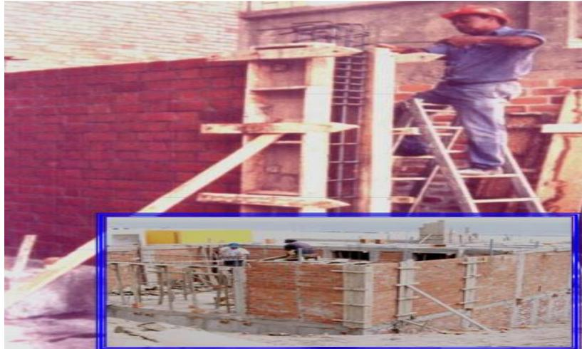
Figura 5. Detalle de Columna en confinamiento de concreto armado
