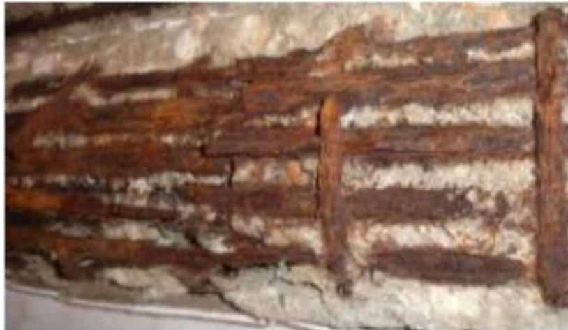
Figura 14. Corrosión. Superficie de viga de concreto corroída.
