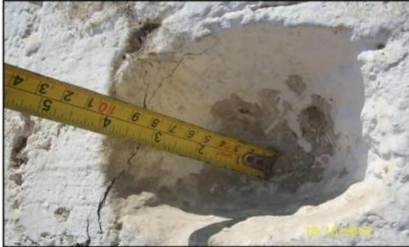
Figura 10. Erosión mecánica la unidad de albañilería.
