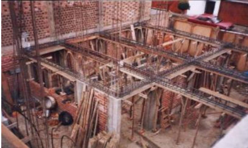
Figura 6. Construcción de viga de concreto armado.
