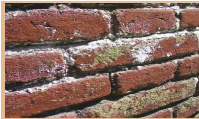
Figura 13. Aparición de eflorescencias en ladrillos, es en las partes más expuestas de las obras de fábrica donde primero afloran las sales solubles.
