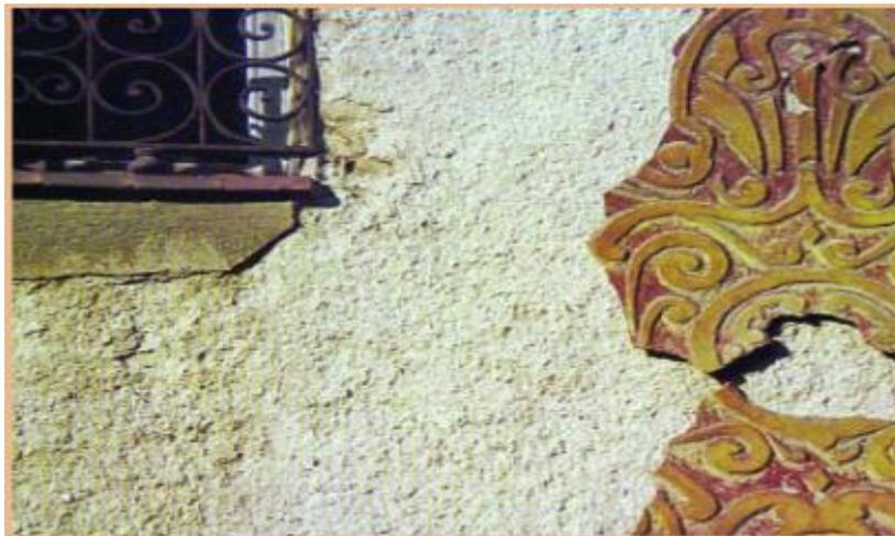
Figura 11. Perdida de la capa exterior del revoco de fachada
