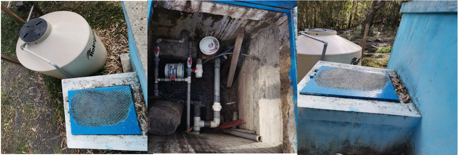
Figura 7: Imagen del segundo Reservorio, del Barrio Apolo (Fuente Propia)
