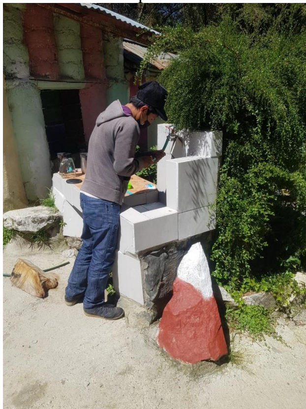
Fotografía 6. Verificando la presión de la última vivienda
