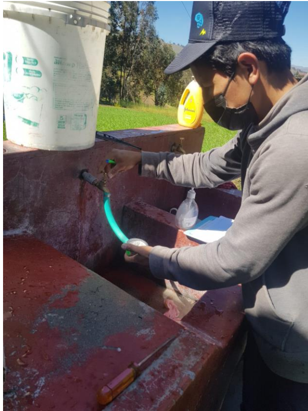
Fotografía 5: Verificando la presión de la vivienda intermedia
