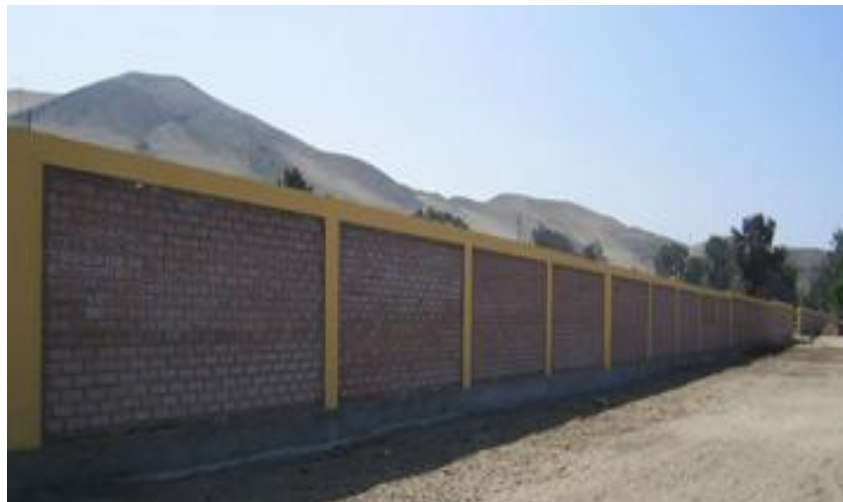
Figura 06. Imagen de cerco perimetral
