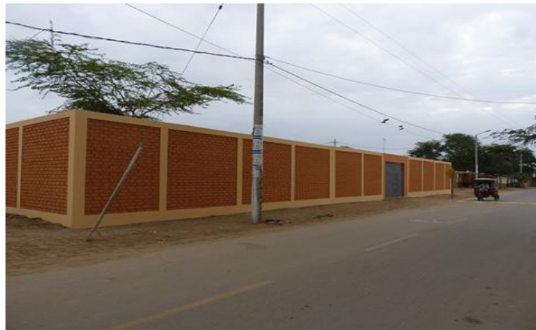
Figura 02. Imagen de cerco perimétrico
