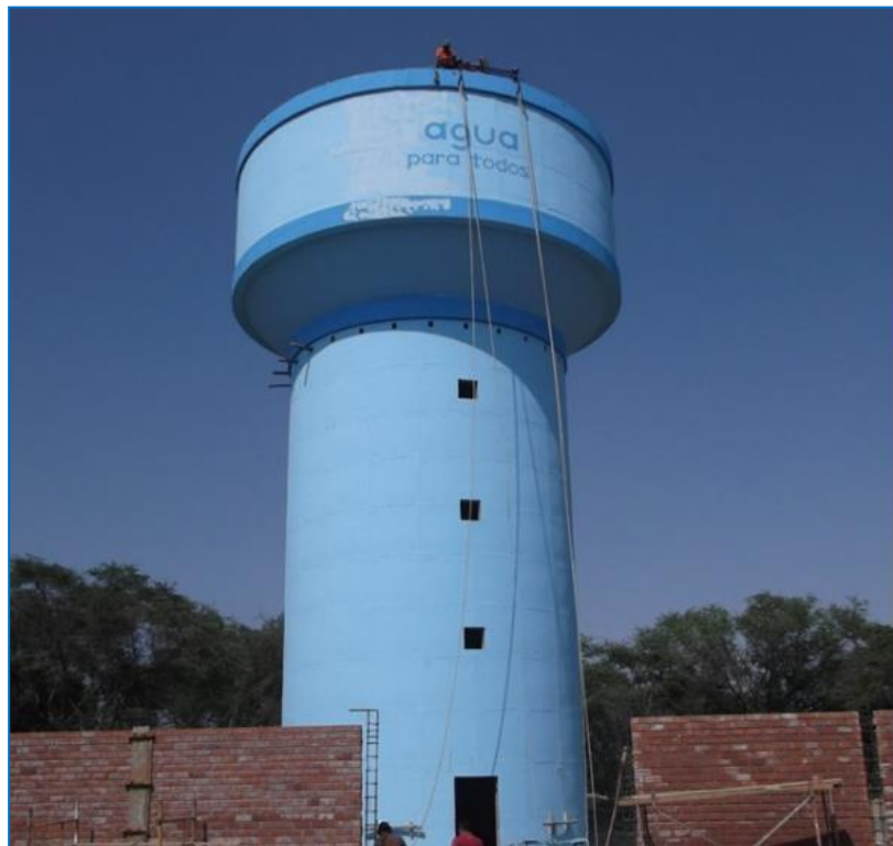
Fuente: KIBE construcciones – 2013
