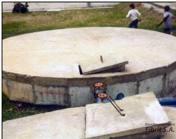
Figura 17: Reservorio enterrado.
