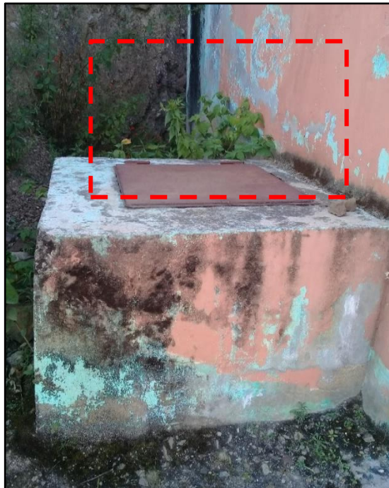
Figura 24: Tapa metálica de la caseta de válvulas del reservorio. Fuente: Elaboración propia.
