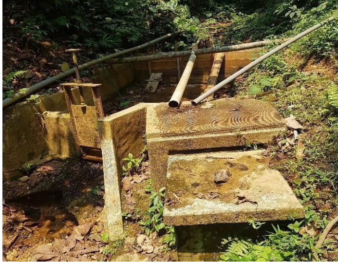
Figura 21: Captación actual de San Isidro
