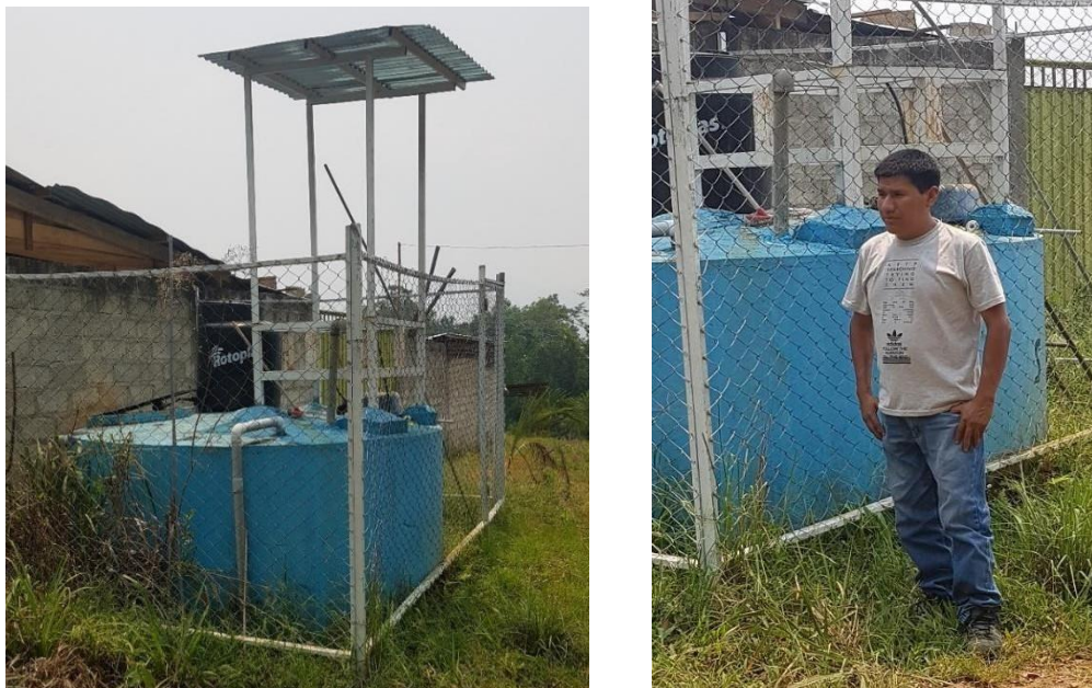
Figura 23: reservorio existente de San Isidro
