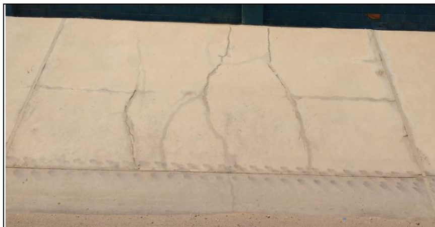
Imagen 32. Grieta Diagonal en el Talud Derecho del Canal
