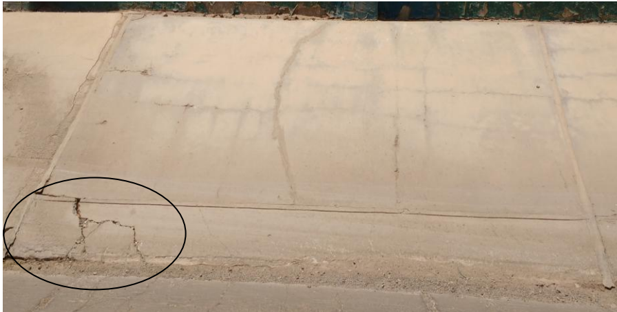
Imagen 45. Distorsión en el Lado Derecho del Canal
