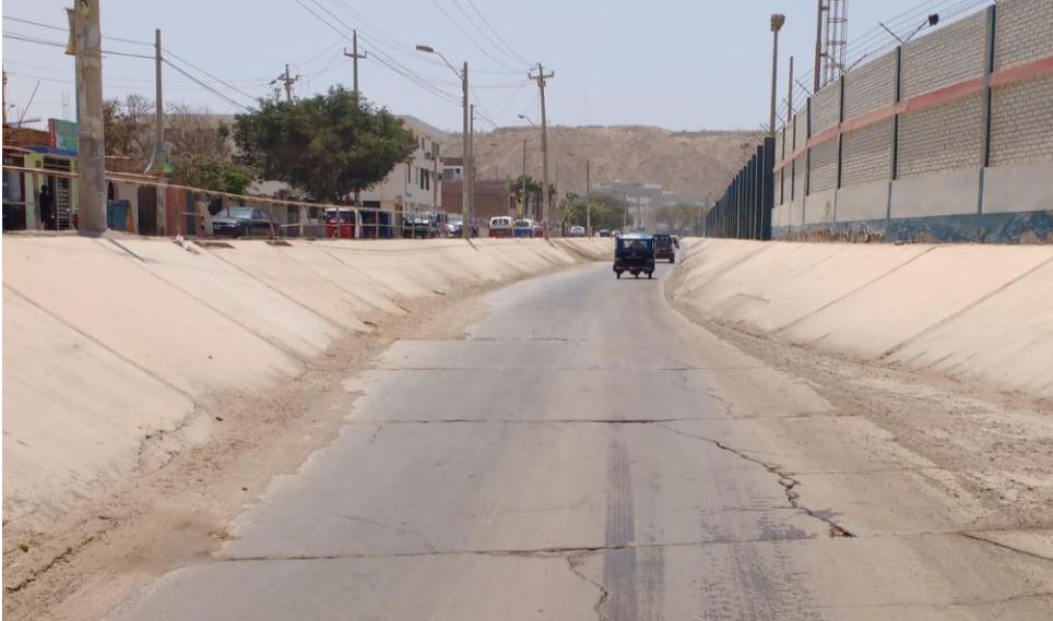
Imagen 25. Vista panorámica del canal de concreto de uso Para Evacuación Pluvial donde se muestra el INICIO DE TRAMO 0+850 km (octubre 2016)
