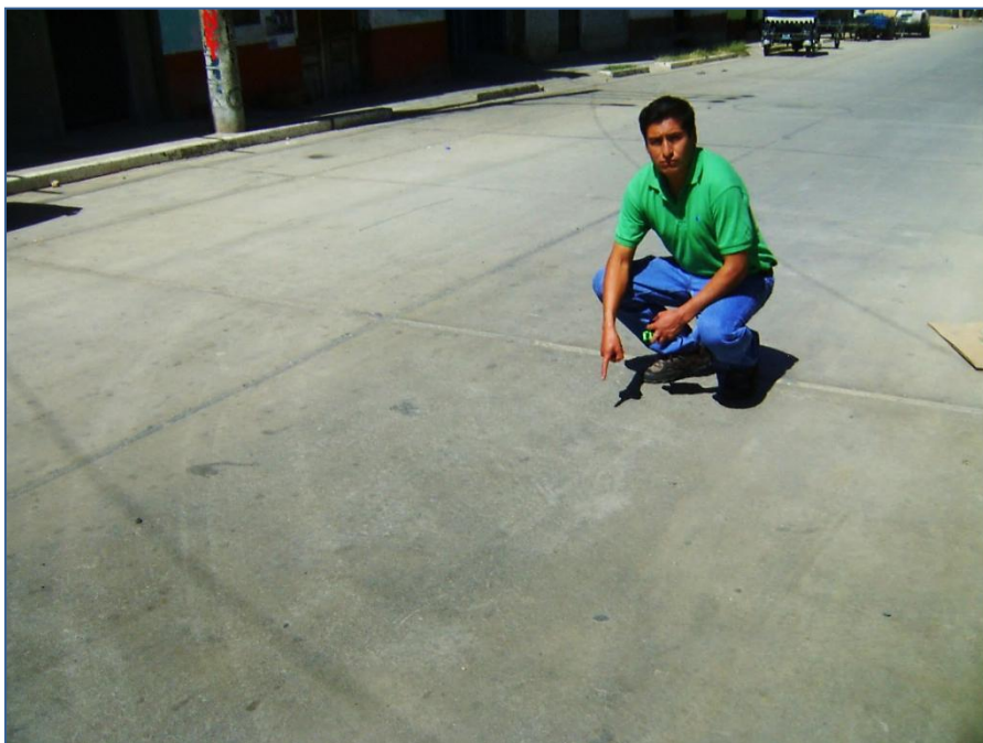
Fotografía N° 14: En la vista se puede apreciar el pulimento de agregados de severidad baja. Av. La Merced
