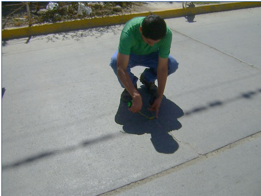
Fotografía N° 02: Mi Persona realizando las mediciones de la grieta lineal en la Av. Meza Arizona
