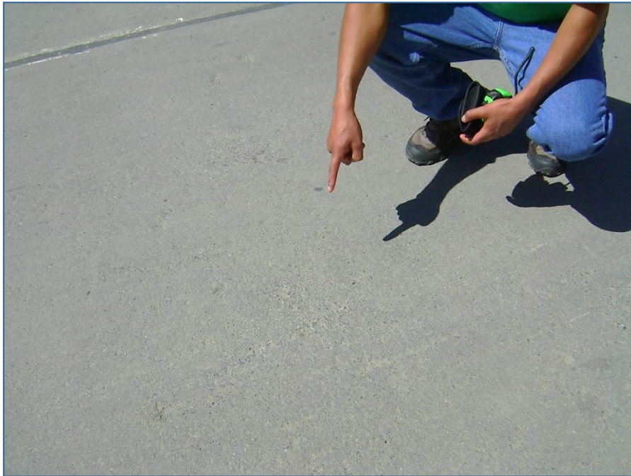
Fotografía N° 14: En la vista se puede apreciar el pulimento de agregados de severidad baja. Av. La Merced
