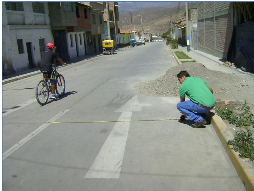
Fotografía N° 12: Mi Persona realizando las mediciones del paño del pavimento. Av. La Merced
