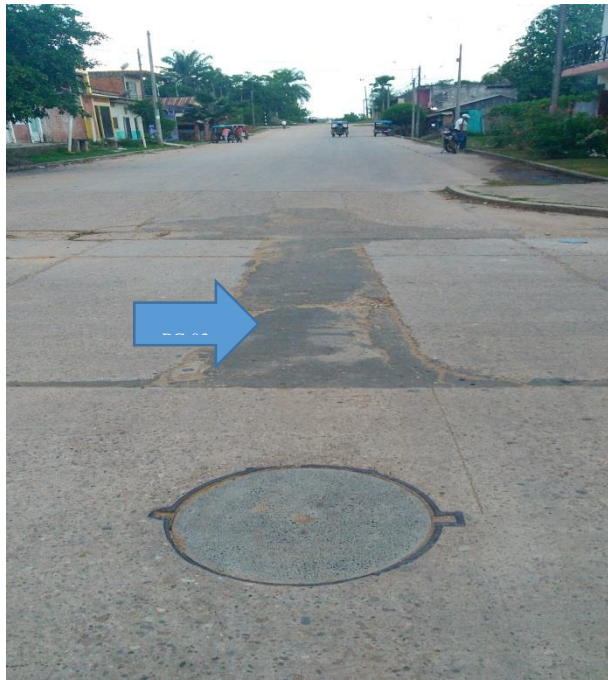
Parche Grande de severidad 03, pulimento de Agregado Cdr.04
