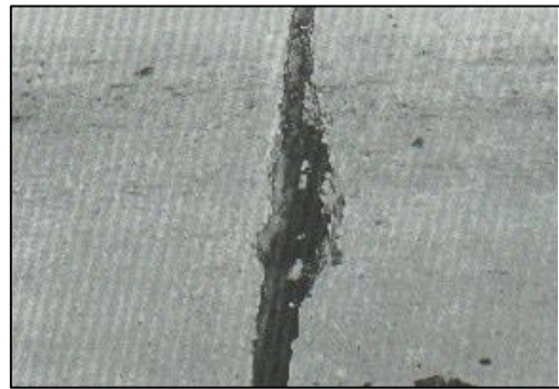
Ilustración 26-1. Severidad media.
