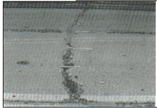
Ilustración 28-2. Severidad alta.
