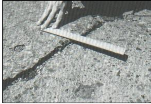
Ilustración 25-2. Severidad media.
