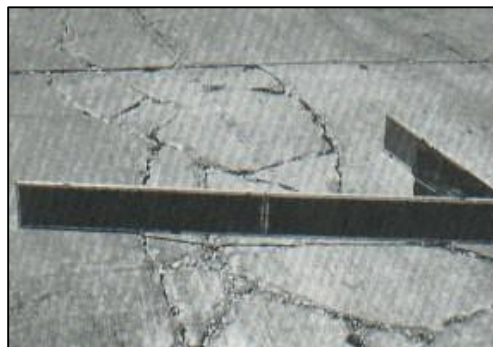
Ilustración 34-3. Severidad alta.
