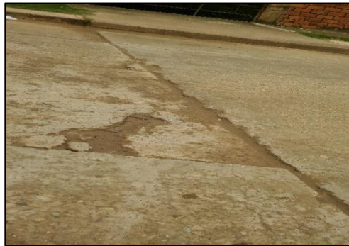
Ilustración 22-3. Severidad alta.
