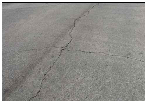
Ilustración 23-2. Severidad alta.
