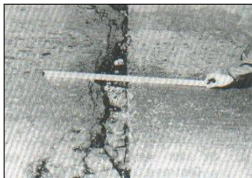
Ilustración 39-3. Severidad alta.
