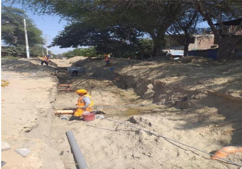
Realizando Conexiones de Alcantarillado en el Sector 1 del AA HH Santa Rosa
