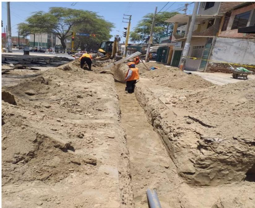
Cierre de tramos en zona ya instalada las conexiones de Agua y Alcantarillado utilizando el zarandeo.
