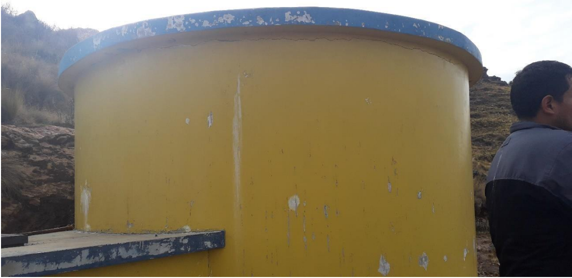
Imagen 15: Reservorio del Caserío de Mungurrall, Distrito de Santiago de Chuco, Provincia de Santiago de Chuco, Departamento de La Libertad - 2019
