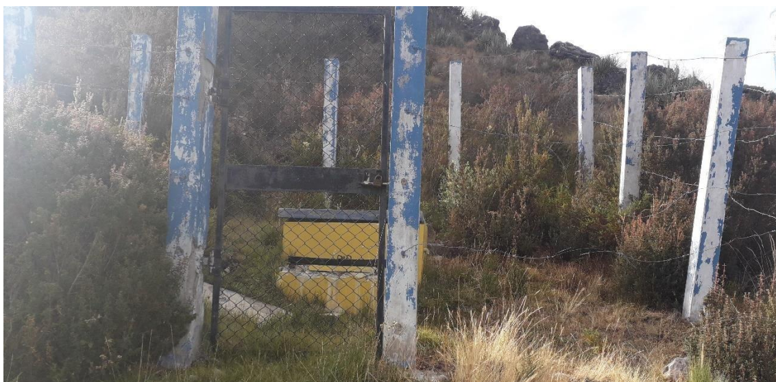
Imagen 14: Cerco perimétrico la cámara de captación del Caserío de Mungurrall, Distrito de Santiago de Chuco, Provincia de Santiago de Chuco, Departamento de La Libertad -2019
