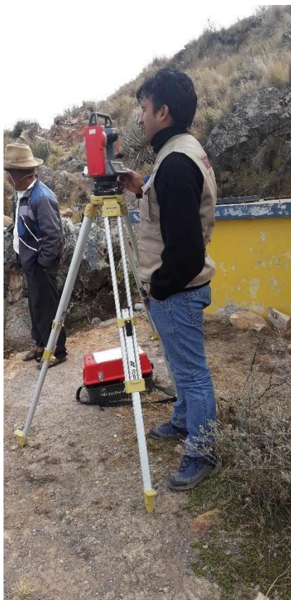
Imagen 23: Levantamiento topográfico del Caserío de Mungurrall, Distrito de Santiago de Chuco, Provincia de Santiago de Chuco, Departamento de La Libertad – 2019
