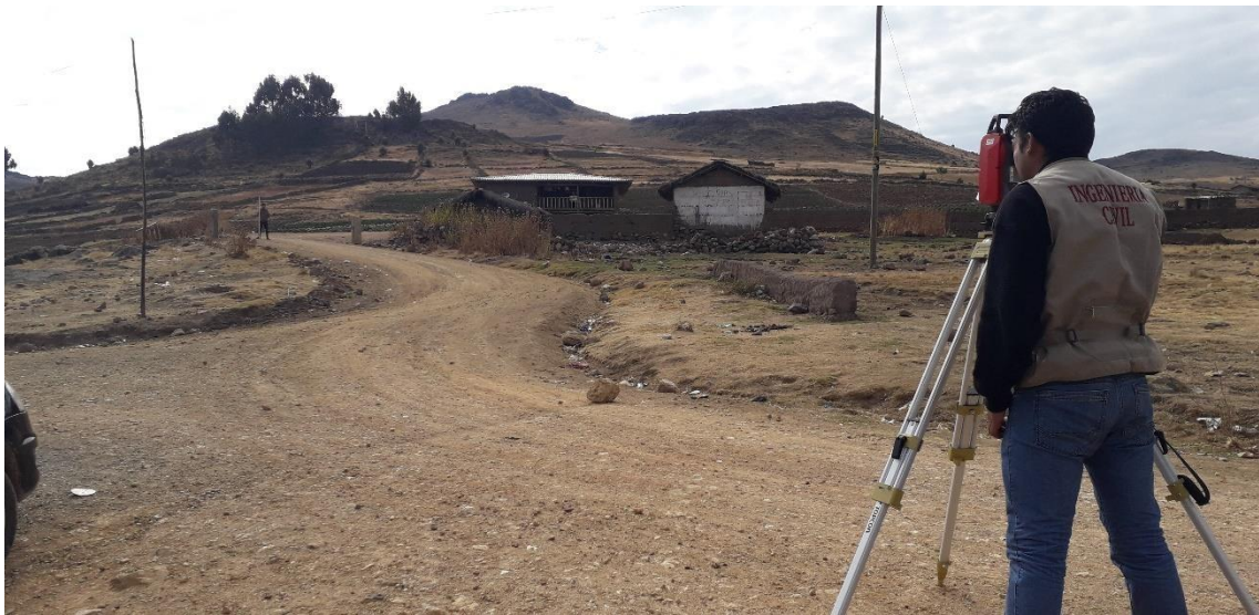
Imagen 25: Levantamiento topográfico del Caserío de Mungurrall, Distrito de Santiago de Chuco, Provincia de Santiago de Chuco, Departamento de La Libertad – 2019
