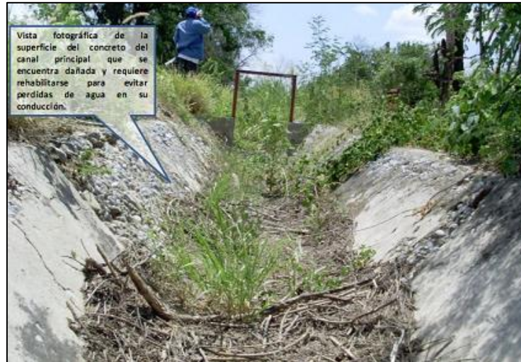
Figura 07: Vegetación en el interior del canal. (Fuente: Roncal M., 2013)
