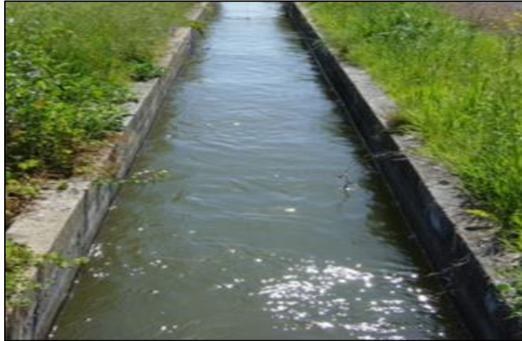
Figura 04: Canal de riego de sección rectangular
