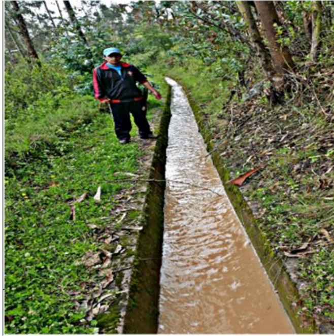
Fotografía 01. Vista panorámica del canal de concreto. Muestra 01. (1+100-1+200).
