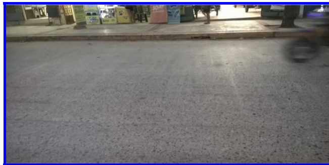
Figura N° 121: Patología de pulimento de agregados sin severidad en la cuadra 5 del Jr. Coronel Portillo
