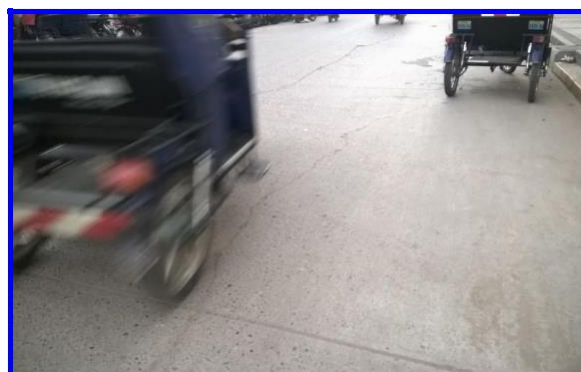
Figura N° 114: Patología de grieta lineal con severidad alta en la cuadra 4 del Jr. Coronel Portillo
