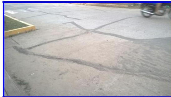
Figura N° 96: Patología de Losa Dividida con severidad Media en la cuadra 1 del Jr. Coronel Portillo
