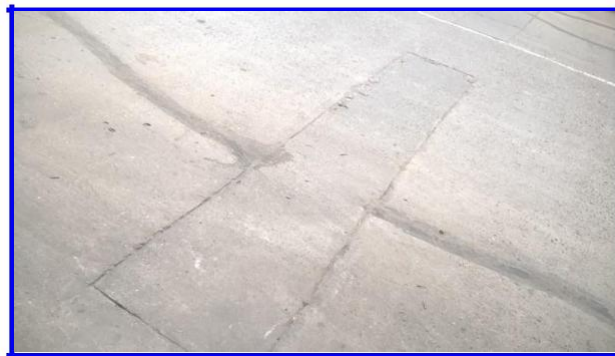
Figura N° 105: Patología de parche grande con severidad baja en la cuadra 2 del Jr. Coronel Portillo
