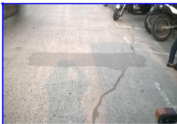
Figura N° 125: Patología de parche grande con severidad baja en la cuadra 6 del Jr. Coronel Portillo
