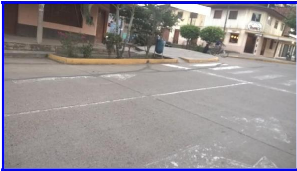
Figura N° 104: Patología de losa dividida con severidad media en la cuadra 2 del Jr. Coronel Portillo
