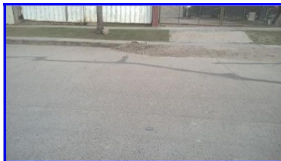
Figura N° 97: Patología de Pulimento de agregados sin severidad en la cuadra 1 del Jr. Coronel Portillo
