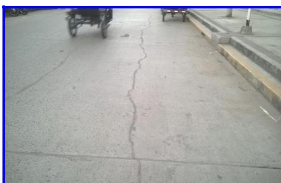
Figura N° 114: Patología de grieta lineal con severidad alta en la cuadra 4 del Jr. Coronel Portillo
