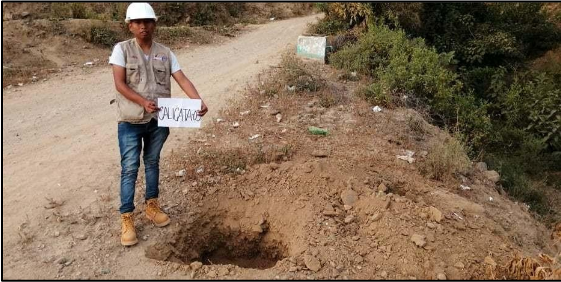
Fotografía 05: Realización de calicata para el estudio de suelo frente al colegio
