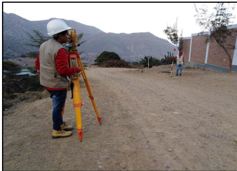
Fotografía 04: Levantamiento topográfico en la carretera en el caserío de Breña hacia el caserío de Isco.
