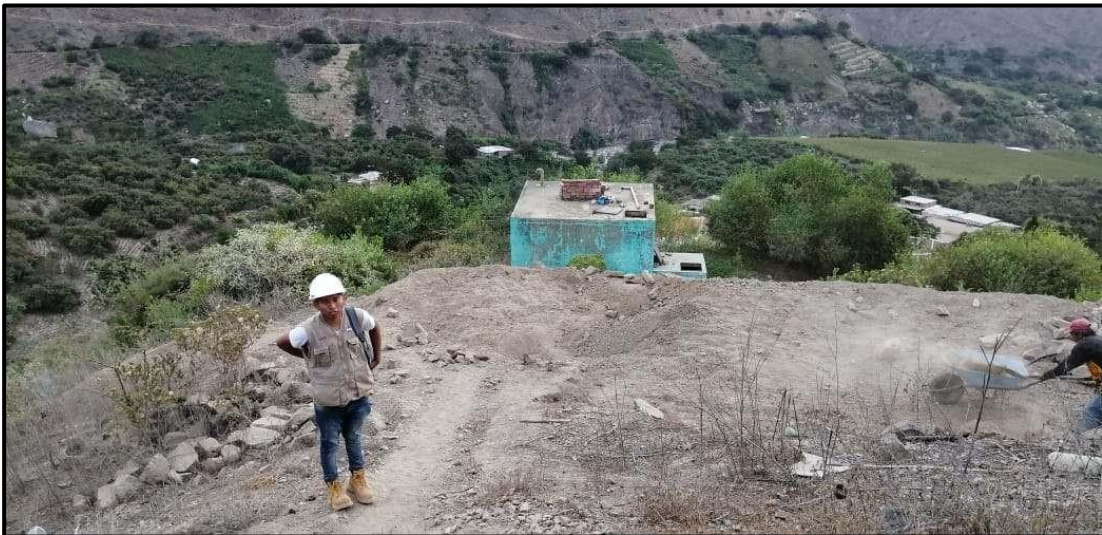
Fotografía 06: Reservorio de almacenamiento del caserío del caserío Isco distrito de Moro, provincia Santa, región Áncash.
