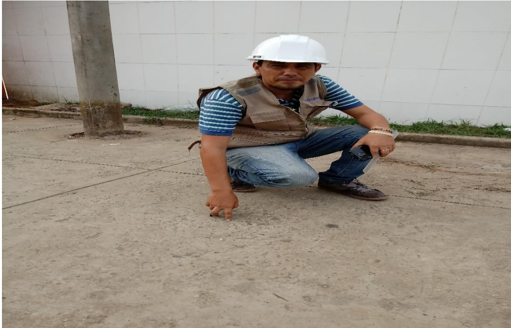
Figura 78: Tipo de daño – Pulimiento de Agregado (Baja)
