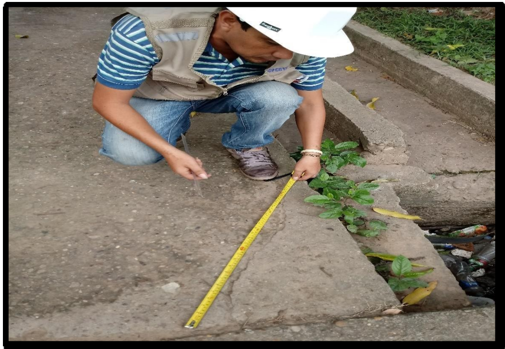
Figura 68: Tipo de daño – Grieta de esquina de esquina (Alta)
