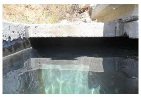
ILUSTRACIÓN 8CAPTACIÓN QUE CARECE DE CERCO Y EL VOLUMEN DE AGUA REBASA POR LOS COSTADOS PUESTO QUE PRESENTA GRIETAS, QUE POR LA CARENCIA DE CERCO LOS ANIMALES QUE PASTEAN POR LA ZONA LO DETERIORAN
