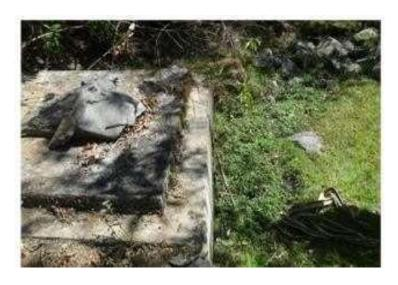
ILUSTRACIÓN 2.CAMARA DE FILTRO DE AGUA, NO CUMPLE FUNCION POR LA CARENCIA DE LIMPIEZA Y MANTENIMIENTO EN ESTA INFRAESTRUCTURA.
