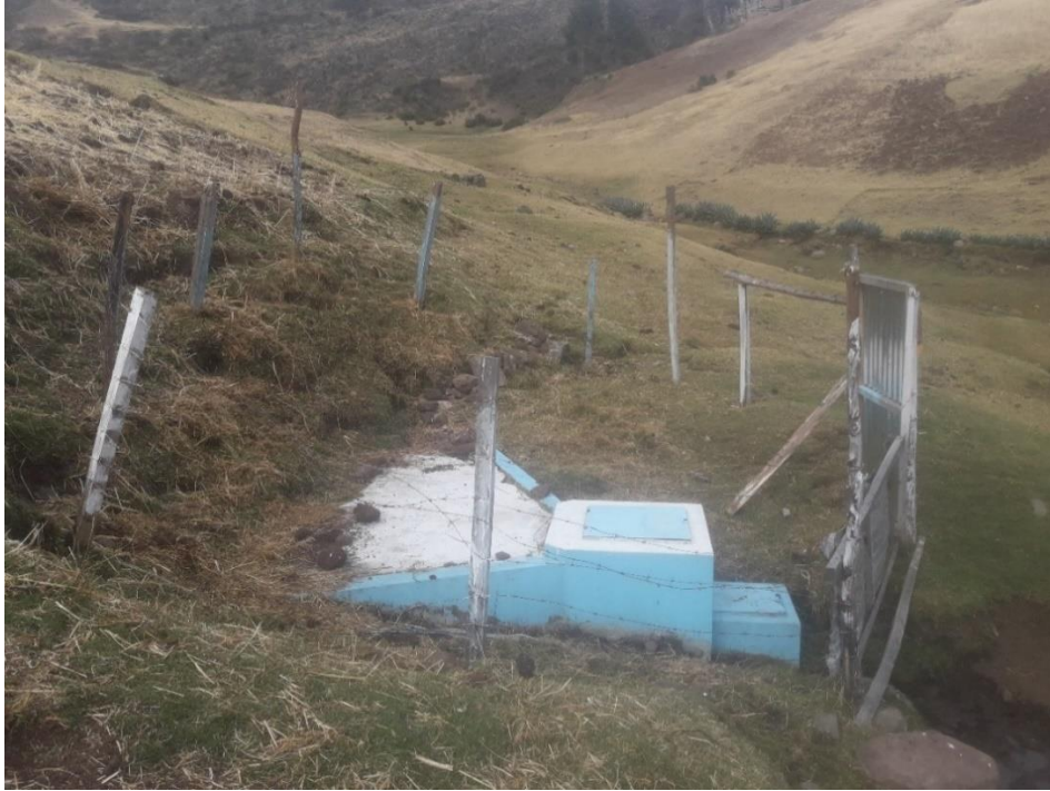
Grafico 30. Cámara de captación de Rayampampa Fuente: Elaboración propia
