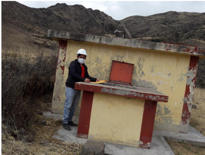
Grafico 36. Tapa sanitaria de Reservorio Antiguo Fuente: Elaboración propia – 2021
