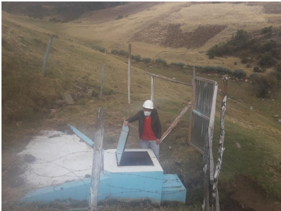
Grafico 31. Taba sanitaria de la cámara húmeda Fuente: Elaboración propia
