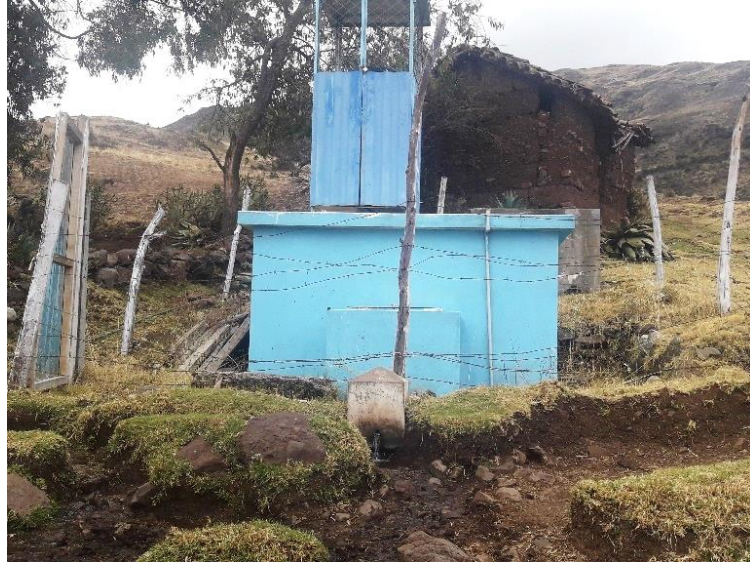
Fotografía 3.2: Vista frontal del Reservorio de Villa del Carmen
