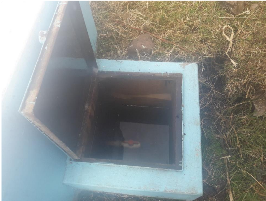
Grafico 32. Caseta de válvula Fuente: Elaboración propia
