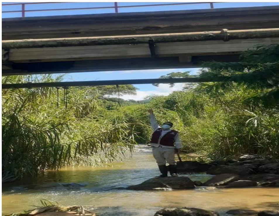
Foto 07: Tubería matriz derecha de agua bajo el puente Timarini 1
