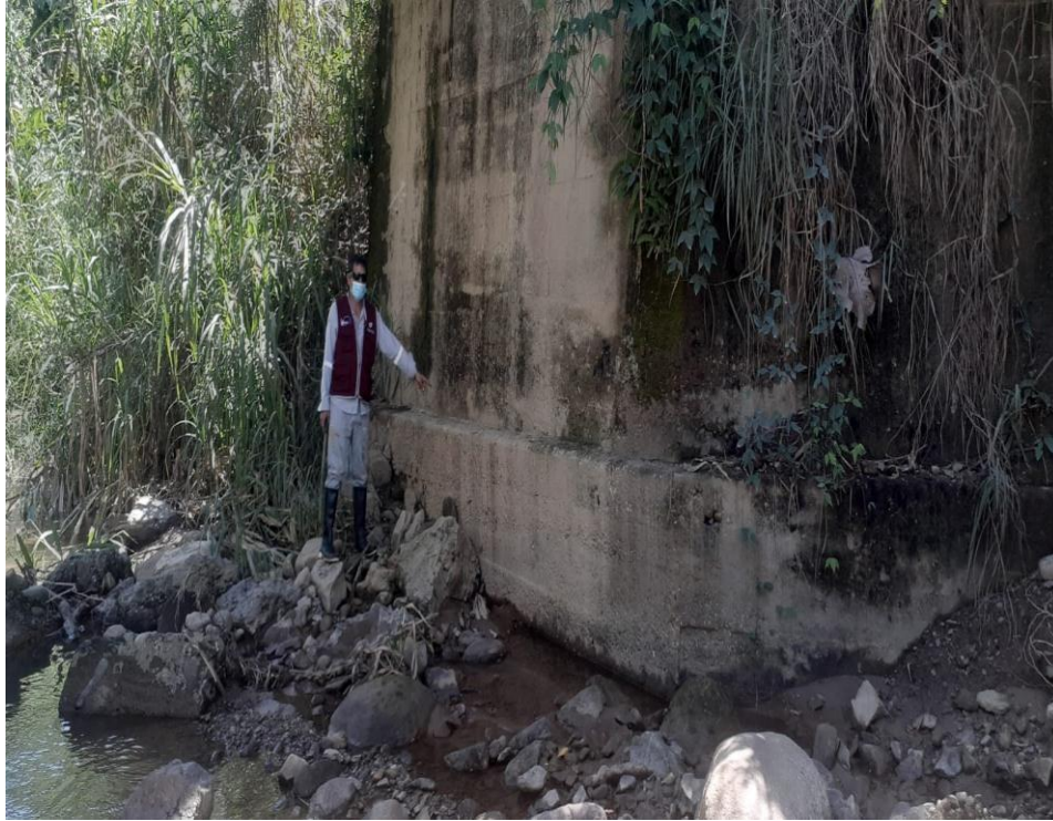
Foto 05: Socavación del estribo de zapata del puente Timarini 1
