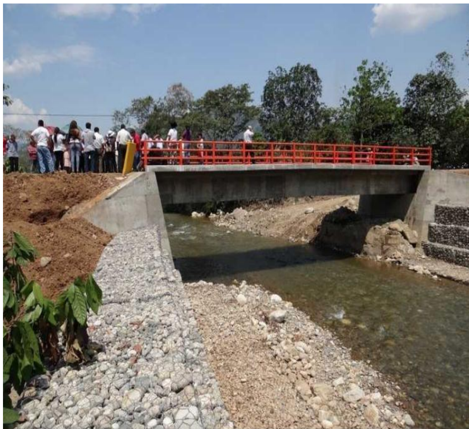
Foto 03: Gaviones instalados nuevo puente Paratushali-Satipo
