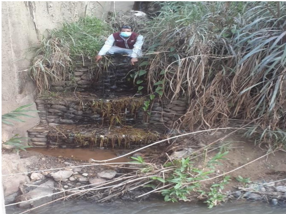
Foto 05: Socavación del estribo de zapata del puente Timarini 1
